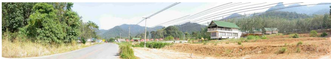
ภาพที่ 3.38 การก่อสร้างอาคารบริเวณตอนล่างของหาดทรายขาว
