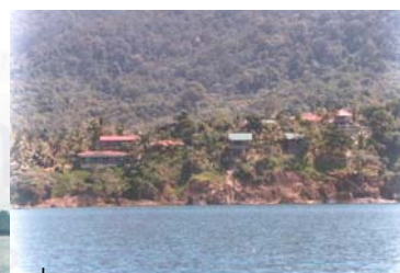
ภาพที่ 3.37 การก่อสร้างอาคาร บริเวณตอนล่างของหาดทรายขาว
