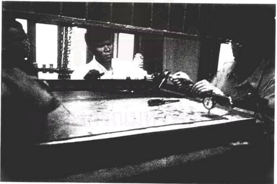
รูปที่ ก-19 แสดงการติดตั้ง Dial Gauge เพื่อใช้วัดการทรุดตัวที่เกิดขึ้น
