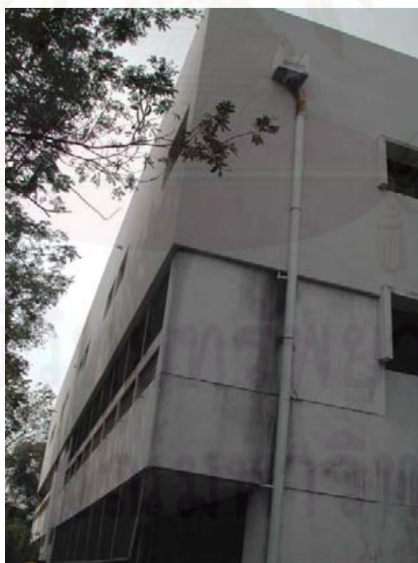
ภาพที่ 4 -18 แสดงการปรับปรุงผนังอาคารด้านทิศตะวันออกและทิศเหนือด้วยวัสดุผนัง EIFS
