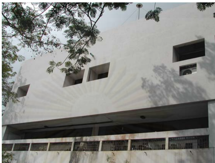
ภาพที่ 4-21 แสดงการปรับปรุงผนังอาคารด้วยวัสดุผนังEIFSโดยเว้นบริเวณช่องกระจก
