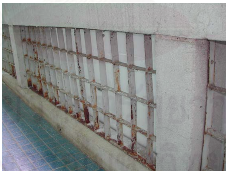
ภาพที่ 4 - 20 แสดงการติดตั้งผนังEIFSบนผนังระเบียงซีเมนต์เหล็ก
