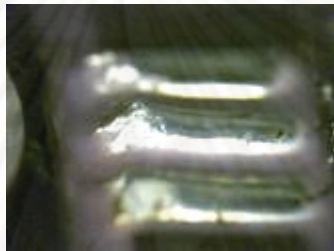
รูปที่ 3.8 การบัดกรีตะกั่วสูงเกินไปกว่าขอบ Base
