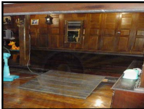
ภาพที่ 4.4 แสดงการจัดทำทางลาดภายในบริเวณบ้านที่มีทางต่างระดับเพื่อใช้ในการเคลื่อนย้ายผู้สูงอายุที่ต้องใช้รถเข็น
