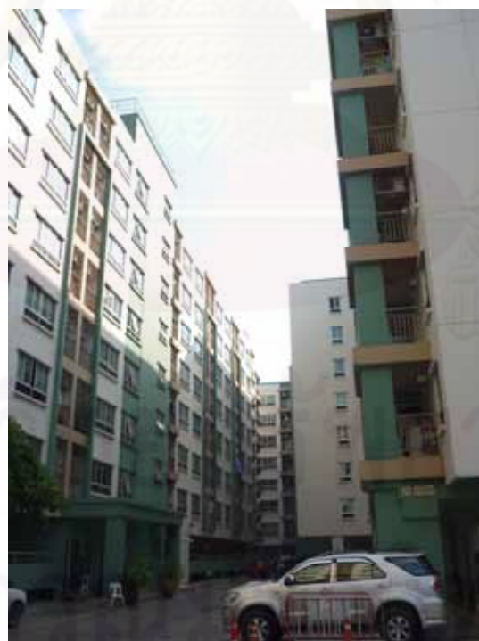
ภาพที่ 5.4 แสดงทัศนียภาพระหว่างอาคาร B1 และ B2 โครงการลุมพินีวิลด์ ศูนย์วัฒนธรรม ช่วงระยะห่างระหว่างอาคาร 6.00 เมตร และ 12.00 เมตร
