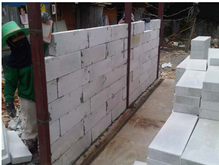
รูปที่ 5.1 แสดงสภาพการทำงานของคนงานก่ออิฐมวลเบา
