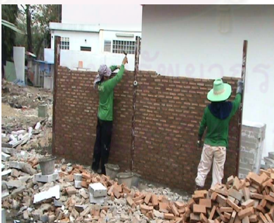
รูปที่ 5.41 แสดงการก่ออิฐมอญที่ระดับสูง คนงานจำเป็นต้องเอื้อมเพื่อก่ออิฐที่ระดับดังกล่าว
