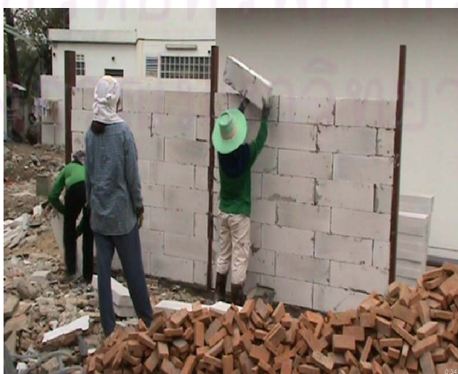
รูปที่ 5.15 แสดงการก่ออิฐมวลเบาที่ระดับสูง คนงานจำเป็นต้องเอื้อมเพื่อก่ออิฐมวลเบาที่ระดับสูง
