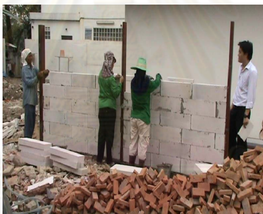
รูปที่ 5.14 แสดงการก่ออิฐมวลเบาที่ระดับความสูงระดับหน้าอก คนงานยืนก่ออิฐได้ปกติ
