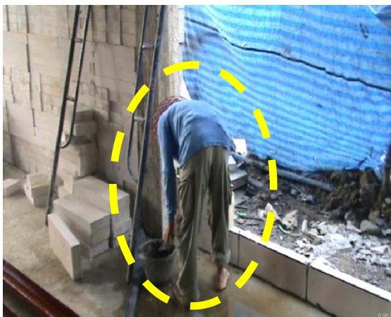
รูปที่ 4.16 แสดงสภาพการก่ออิฐที่อยู่ในระดับต่ำ ซึ่งคนงานใช้วิธีก้ม และสภาพหลังอยู่ในสภาพที่โค้ง (กลุ่มข้อมูล 4 รหัสท่าทาง 2121 ระดับความอันตราย 2)
