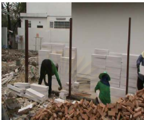
รูปที่ 5.13 แสดงสภาพการก่ออิฐมวลเบาที่ระดับความสูงต่ำ คนงานต้องนั่งยอง หรือต้องก้ม
