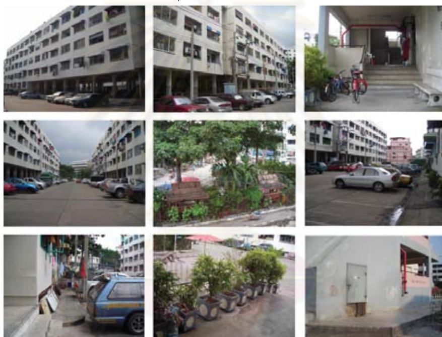
ภาพที่ 3. 3 แสดงตัวอย่างลักษณะกายภาพภายนอกบริเวณอาคาร 1-4 ของ นิติบุคคลอาคารชุดเคหะชุมชนธนบุรี 1 ที่มา : จากการสำรวจ
