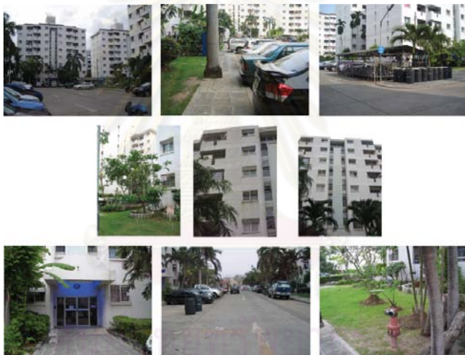
ภาพที่ 3.33 แสดงตัวอย่างสภาพภายนอกบริเวณอาคาร A1-A12 ของ
