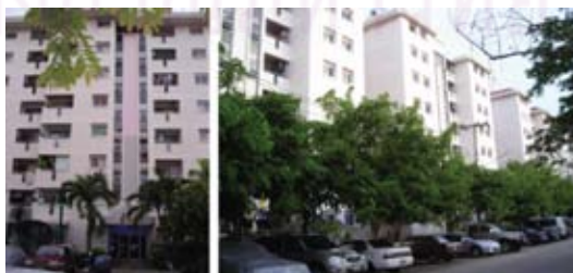
ภาพที่ 3.38 ภาพถ่ายอาคารชุดพักอาศัยในนิติบุคคลอาคารชุดเคหะชุมชนธนบุรี 8
