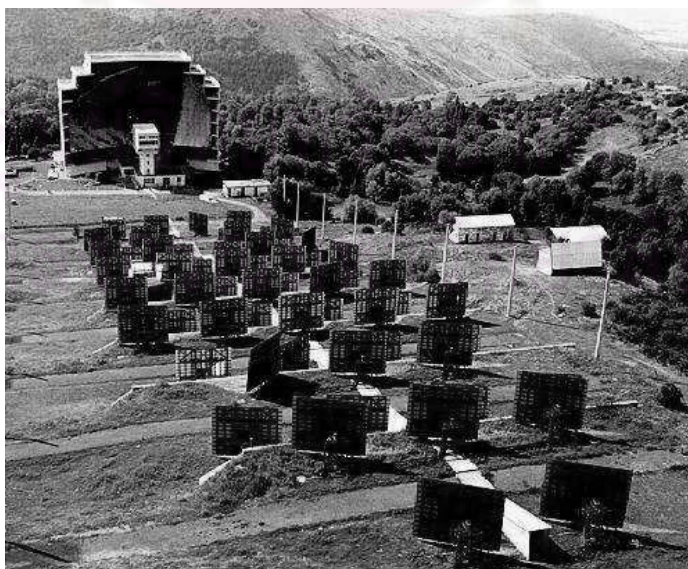
รูปที่ 2.13 ระบบเตาเผาสุริยะที่ไอเอ็มพี-ซีเอ็นอาร์เอสประเทศฝรั่งเศส
