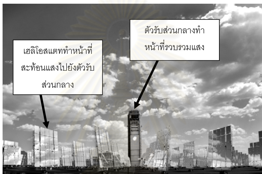
รูปที่ 2.5 ระบบตัวรับส่วนกลางของห้องปฏิบัติการแห่งชาติซานเดียประเทศสหรัฐอเมริกา
