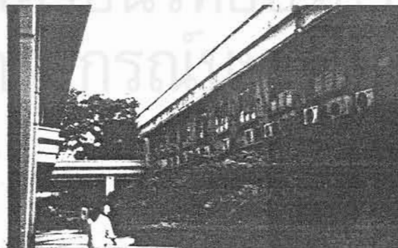
รูปที่ 2.7 แสดงอุปกรณ์บังแดดแนวนอนซึ่งใช้เป็นที่วางคอมเพรสเซอร์ด้วย
