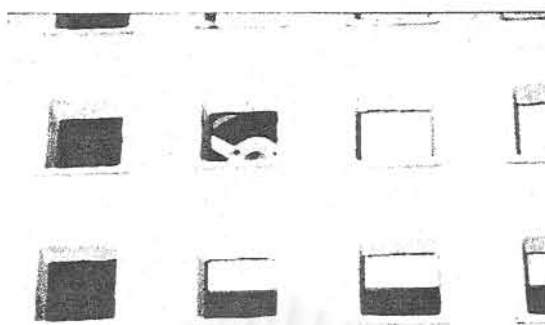
รูปที่ 2.2 แสดงช่องระบายอากาศเหนือประตูที่ถูกตีปิดด้วยไม้อัด
