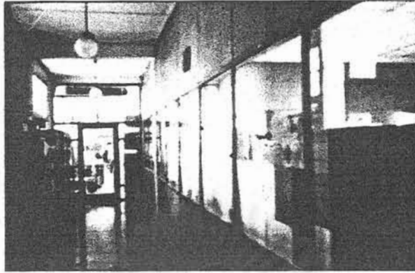
รูปที่ 2.12 แสดงผนังกระจกที่ติดสติ๊กเกอร์ลวดลายเพื่อพรางตา
