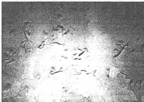
รูปที่ 2.1 แสดงสีที่หลุดร่อนจากการทาสีทับหลายครั้งโดยไม่ได้ล้างสีเดิมออกก่อน
