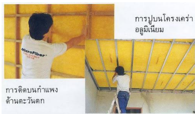
ภาพที่ 2.9 การติดตั้งฉนวนใยแก้วที่ตำแหน่งต่างๆ
