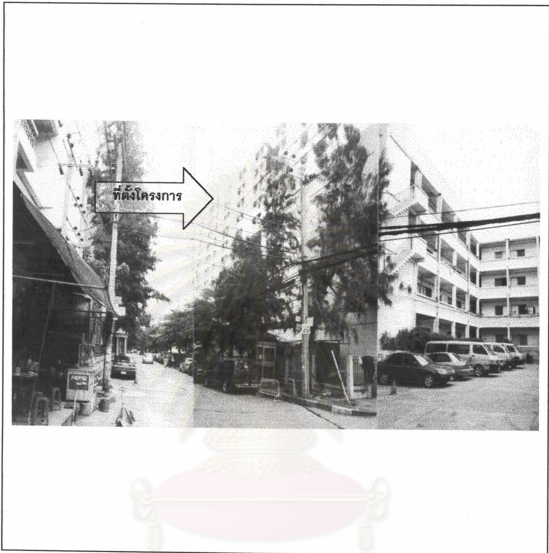
ภาพที่ 3 : สภาพทั่วไปของอาคารชุดเอเบคคอนโดทาวน์
