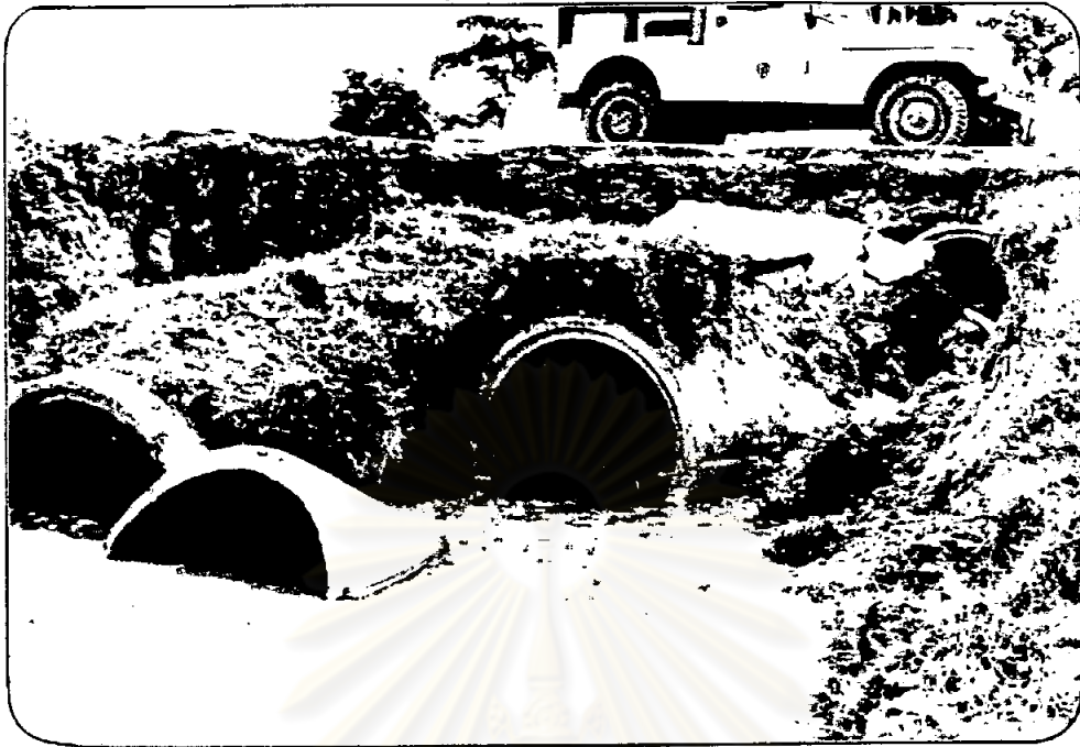
รูป 6-2 การกีดเขาะปากทางน้ำออกของท่อ ทำให้ดินรองรับท่อหาย ท่อทรุด และถนนขาด
