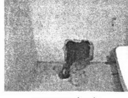
งานระบบประปา
