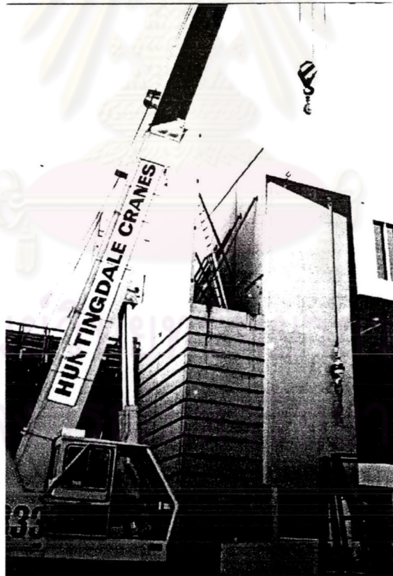
ภาพ 2.5 การก่อสร้างระบบผนังรับน้ำหนัก
