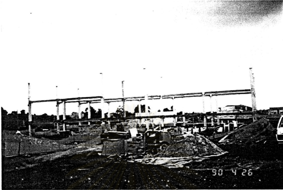
ภาพ 2.4 การก่อสร้างระบบโครงสร้างคาน
