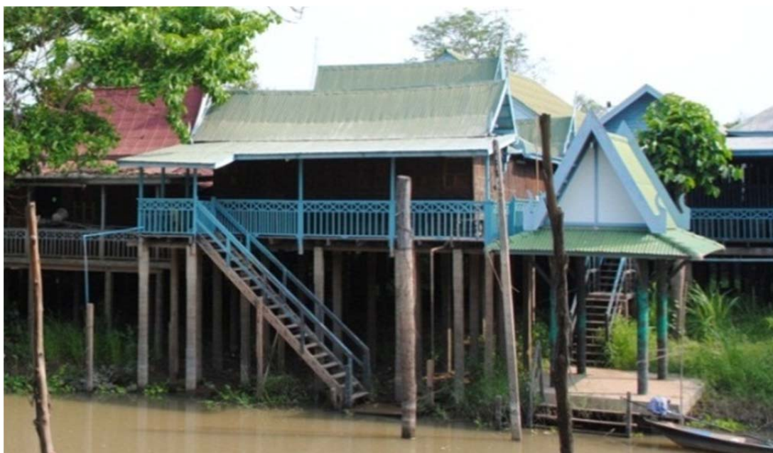
รูปที่ 3.13 เสาปักหน้าเรือ เพื่อกันไม่ให้แพลูกบวบสำหรับเทียบเรือลอยมาชนกับเรือ
