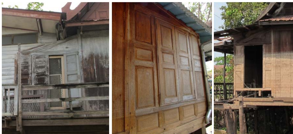
รูปที่ 4.56 ฝาเลื่อนที่พบในเรือนแพทรงไทย
