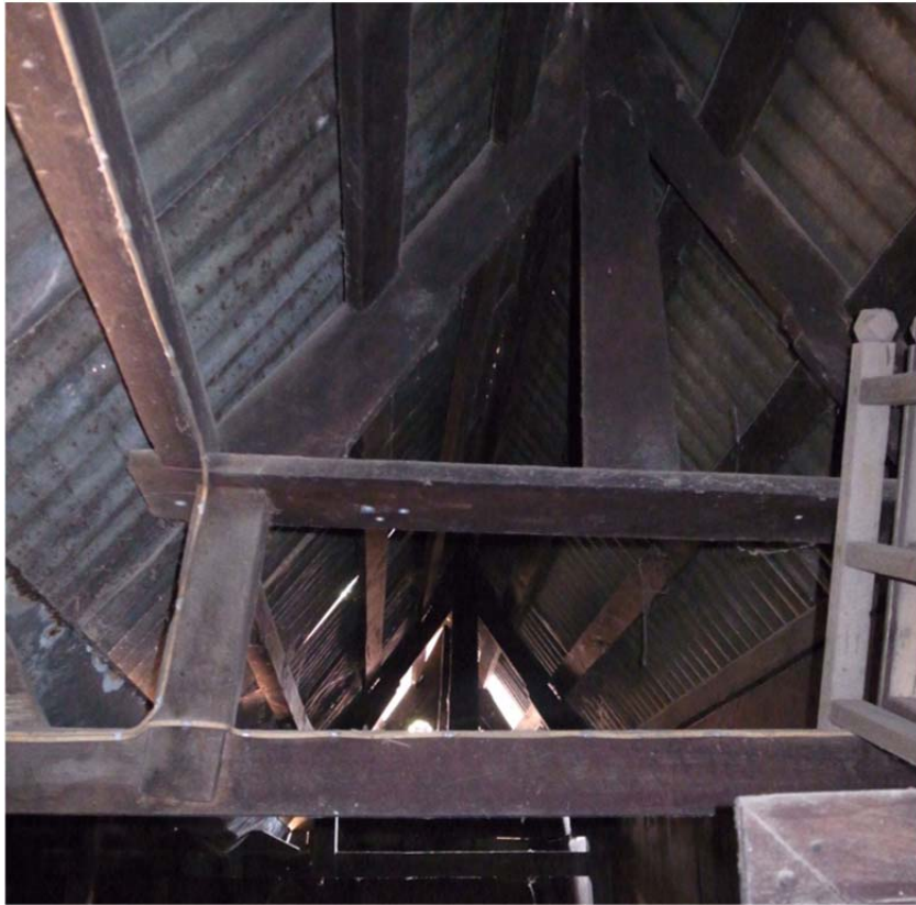
รูปที่ 3.64 ลักษณะโครงสร้างหลังคาของเรือนแพทรงไทยต้นแบบ (Hw-6)
