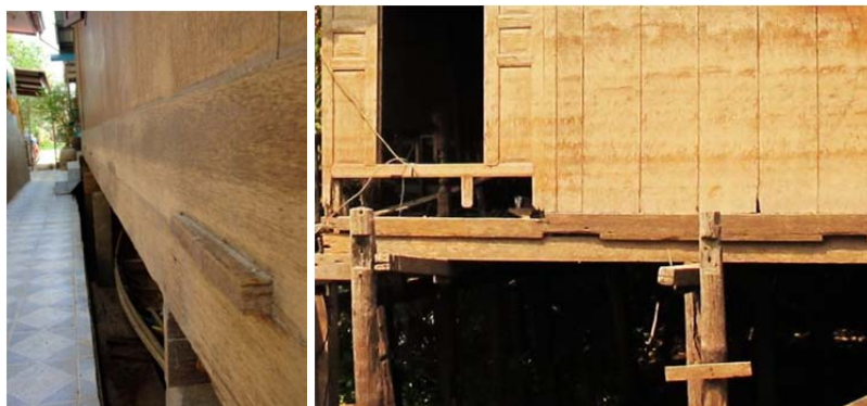
รูปที่ 4.44 ภาพแสดงพริ้งของเรือนแพทรงไทย
