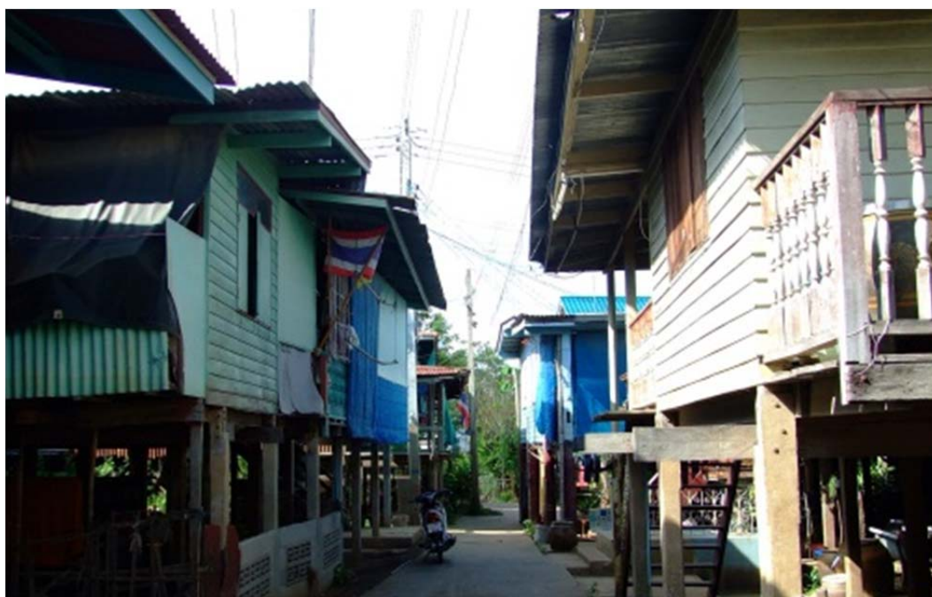
รูปที่ 3.9 ตัวอย่างบ้านไม้จั่วผสม ผสมโครงสร้างคอนกรีตเสริมเหล็ก
