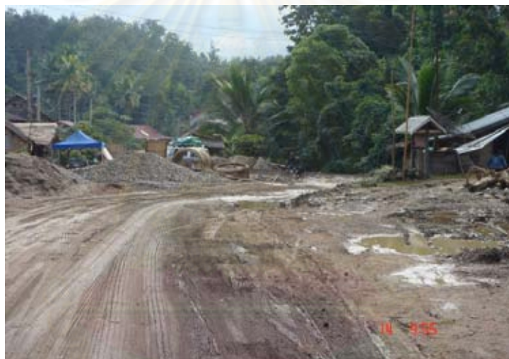
รูปภาพที่ 4.2 ถนนช่วงที่ผ่านภูเขา ระยะทาง 230 กิโลเมตร และช่วงที่เป็นลูกรังอัดแน่น
