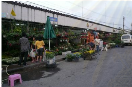
สภาพทางเท้าบริเวณท่าเรือที่มีลักษณะแคบและไม่เหมาะสม
