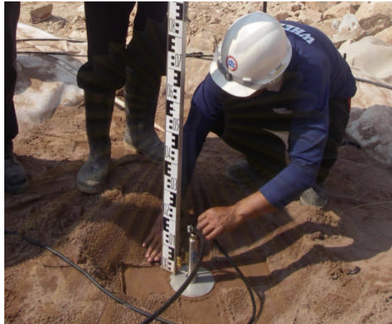
รูปที่ 4.30 แสดงการติดตั้งเครื่องมือ
