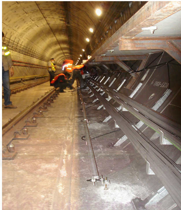
รูปที่ 3.12 การติดตั้ง EL-Beam
