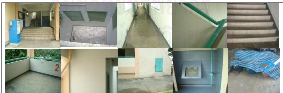
รูปภาพที่ 3.3 ลักษณะกายภาพภายในอาคาร อาคาร 1-6
