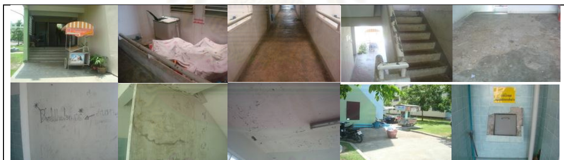
รูปภาพที่ 3.33 ลักษณะกายภาพภายในอาคาร อาคาร 17-18
