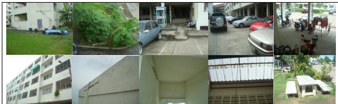
รูปภาพที่ 3.18 แสดงลักษณะกายภาพภายนอกอาคาร อาคาร 29-32
