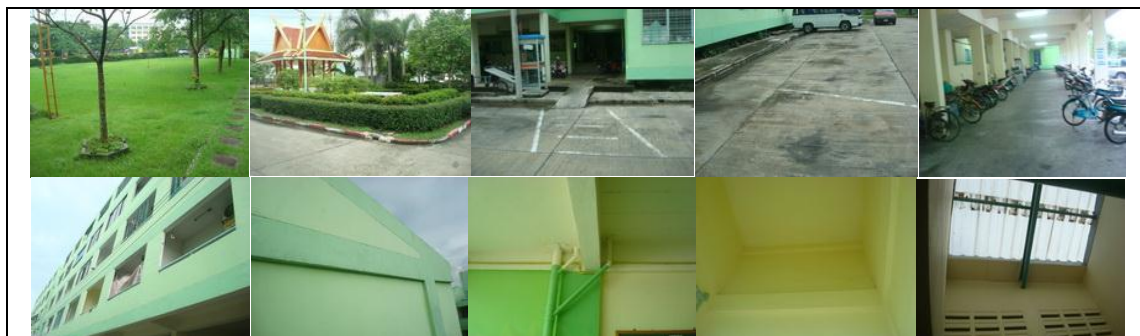
รูปภาพที่ 3.8 แสดงลักษณะกายภาพภายนอกอาคาร อาคาร 7-11
