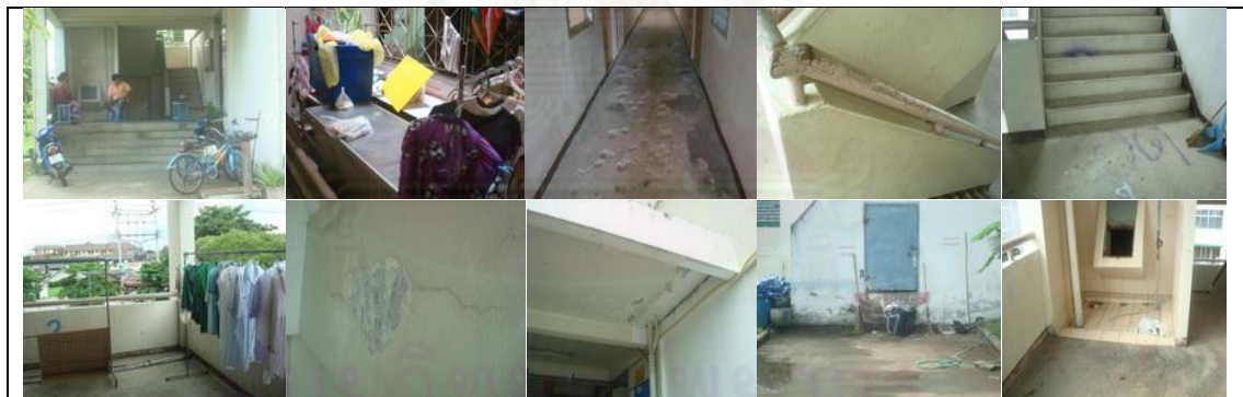
รูปภาพที่ 3.13 แสดงลักษณะกายภาพภายในอาคาร อาคาร 25-28
