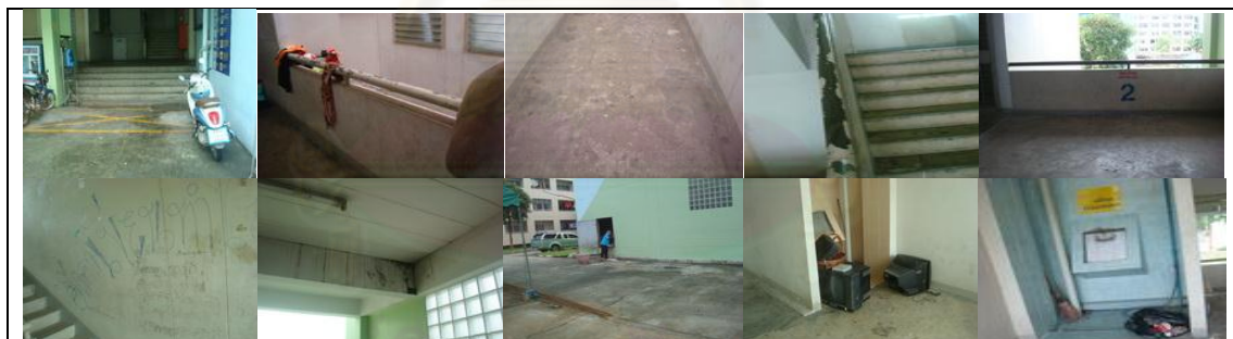
รูปภาพที่ 3.27 ลักษณะกายภาพภายในอาคาร อาคาร 12-13
