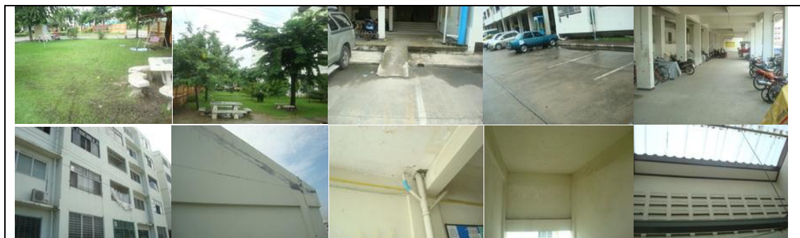
รูปภาพที่ 3.12 แสดงลักษณะกายภาพภายนอกอาคาร อาคาร 25-28
