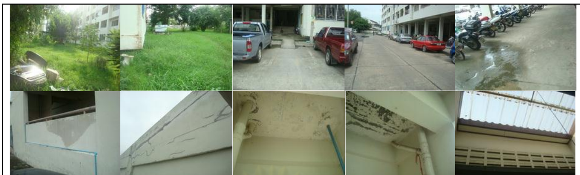
รูปภาพที่ 3.22 แสดงลักษณะกายภาพภายนอกอาคาร อาคาร 33-36
