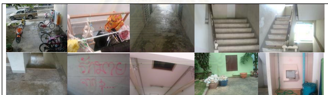
รูปภาพที่ 3.41 ลักษณะกายภาพภายในอาคาร อาคาร 19-21
