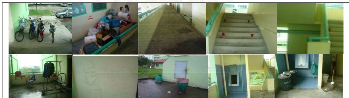
รูปภาพที่ 3.9 แสดงลักษณะกายภาพภายในอาคาร อาคาร 7-11
