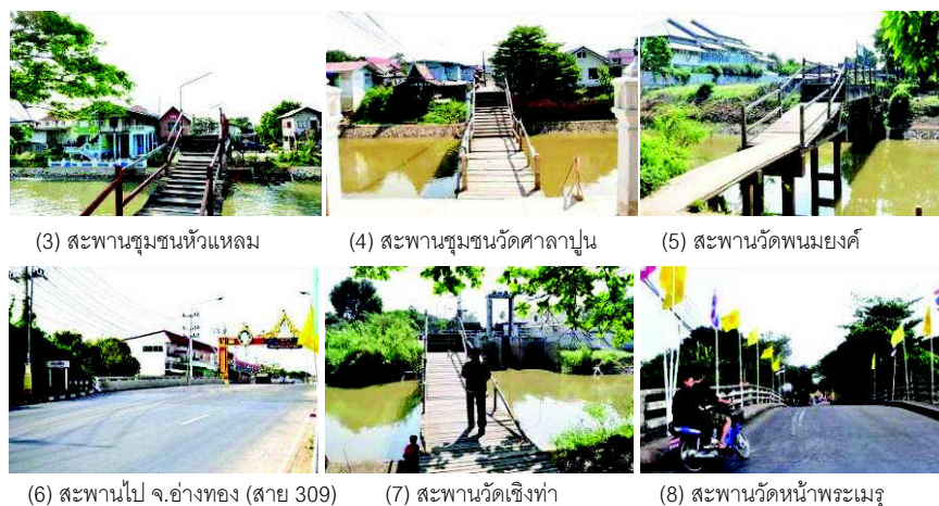
รูปที่ 4.15 สะพานข้ามระหว่างพื้นที่เกาะเมืองกับพื้นที่รอบนอก
