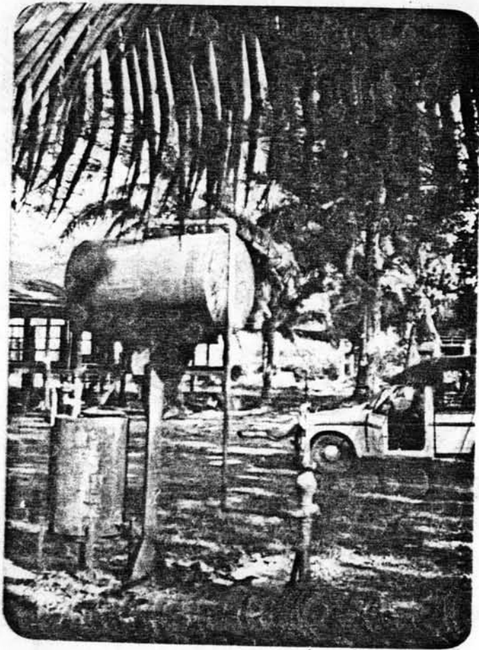
รูปที่ 5.12 บ่ออากาศที่วัดโบสถ์เจริญธรรมซึ่งติดตั้ง ตั้งรองสนิมเหล็กสภาพปัจจุบันน่ากรวย เนื่องจากสนิมเหล็ก (เก็บ ธันวาคม พ.ศ. 2524)
