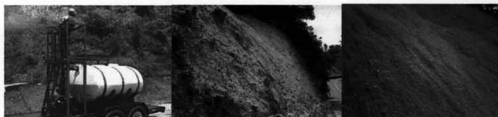
รูปที่ 4.43 แสดงลักษณะการป้องกันพื้นที่ลาดชันด้วยวิธีการพ่นปลูกหญ้า
