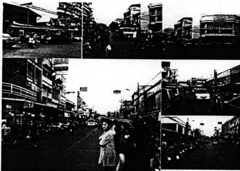
ภาพที่ 3.16 สภาพอาคารบริเวณถนนสระสง
