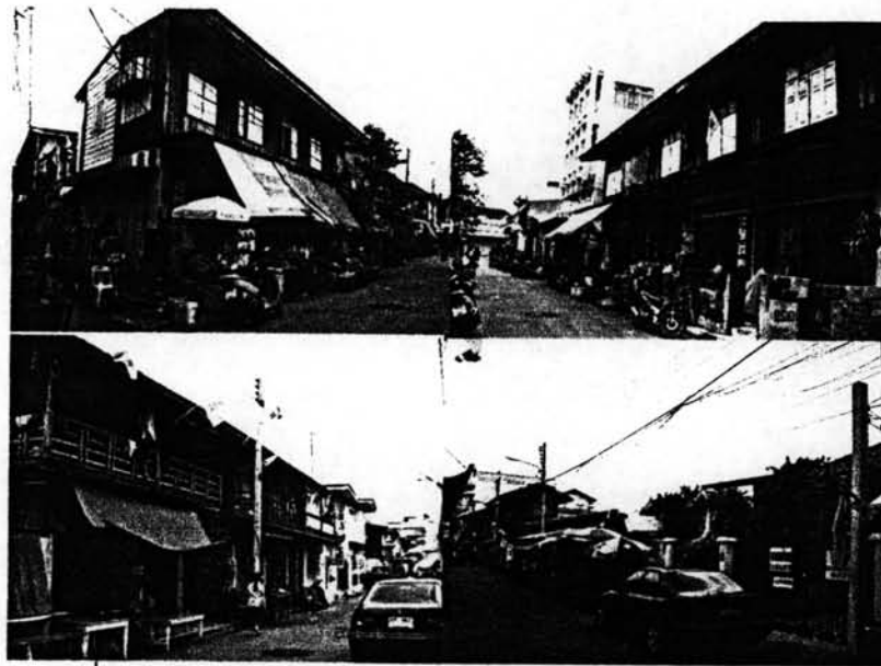
ภาพที่ 3.20 สภาพอาคารบริเวณถนนพหลุสุข
