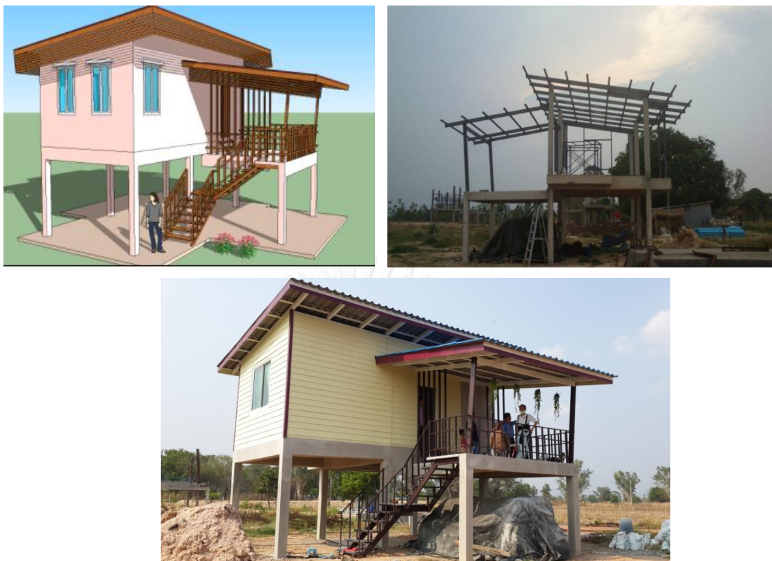
บ้านมั่นคงแรงงานสังคมเพื่อน ปราจีนบุรี
