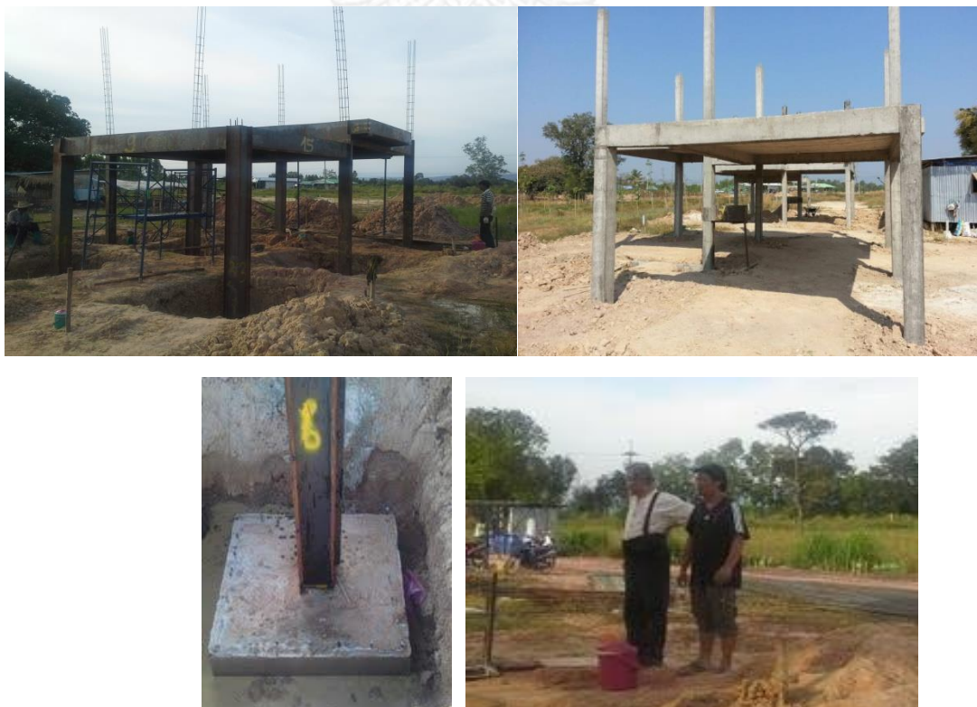
รูปที่ 4- 18 ไม้แบบเหล็กนวัตกรรมการก่อสร้าง ที่ช่วยลดต้นทุนค่าแรงงานและต้นทุนการก่อสร้าง
