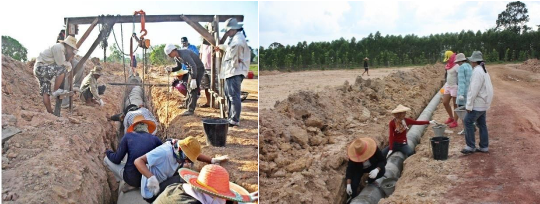
รูปที่ 4- 17 สมาชิกช่วยกันวางท่อระบายน้ำภายในหมู่บ้านแรงงาน
