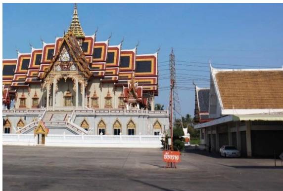
ภาพที่ 4.5 มีสิ่งกีดขวางที่เป็นอันตรายคือเสาไฟฟ้าอยู่บนถนน
