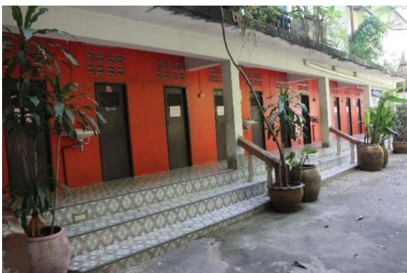
ภาพที่ 4.44 ห้องน้ำใช้วัสดุพื้นผิวเป็นกระเบื้องที่ลื่น
