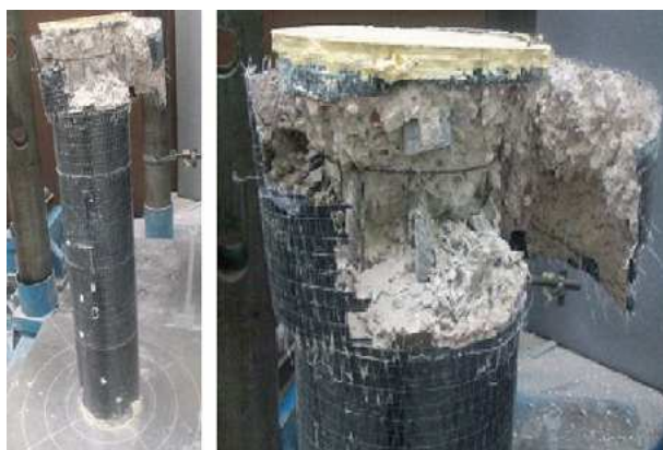
ภาพที่ 2.6 การวิบัติของเสาคอนกรีตภายหลังการซ่อมแซมด้วยCFRP และอิพอกซีเรซิน
