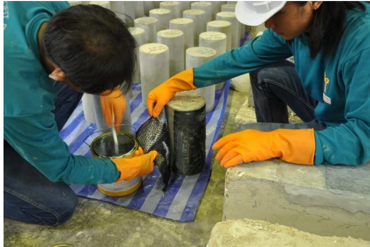
ภาพที่ 4.10 การติดตั้งแผ่น CFRP
