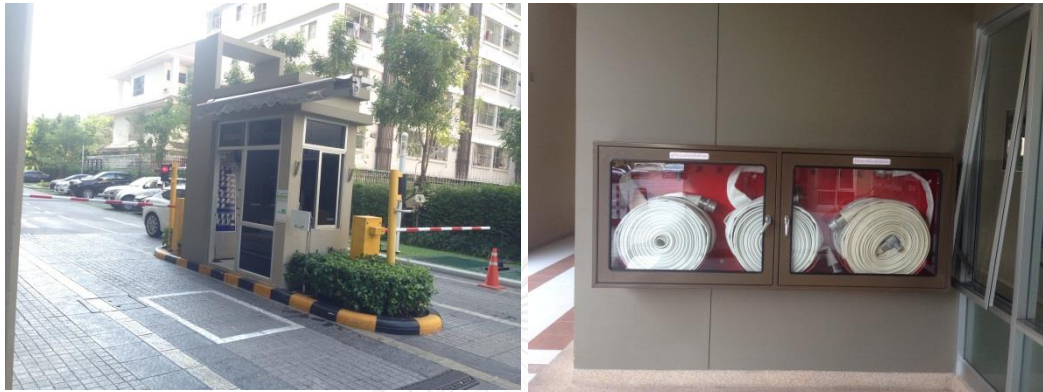
ภาพที่ 4.4 ระบบรักษาความปลอดภัย ซ้าย ไม้กั้นทางเข้าไฟฟ้า ขวา ตู้ดับเพลิงใต้อาคาร
