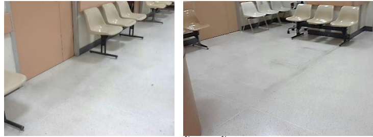
ภาพที่ 4.35 สภาพพื้นของพื้นที่พักรอตรวจ
