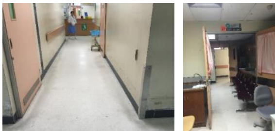
ภาพที่ 4.80 สภาพพื้นของพื้นที่พักรอตรวจ
