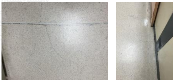
ภาพที่ 4.79 สภาพพื้นของพื้นที่พักรอตรวจ
