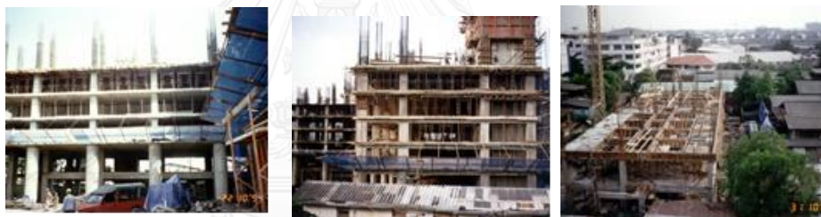
รูปภาพที่ 4.8 การก่อสร้างอาคาร
