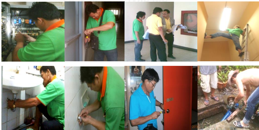
รูปภาพที่ 5.6 งานงานดูแล บำรุงรักษาระบบสาธารณูปโภคและบริการซ่อมแซมอุปกรณ์ภายในห้อง
