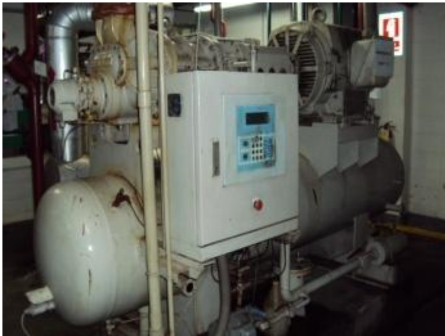
รูปที่ 4-10 คอมเพรสเซอร์สำหรับตู้แช่แข็งแบบเฟลทนอนน เป็นชนิดสกู รุ่น MCN200L-EX2 และ N200VLD-HD ของ MYCOM ขนาด 200 และ 190 kW
