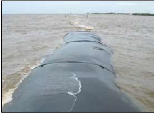
(ก) การวางไส้กรอกทราย (geo-membrane) ใน อำเภอคลองด่าน จังหวัดสมุทรปราการ
