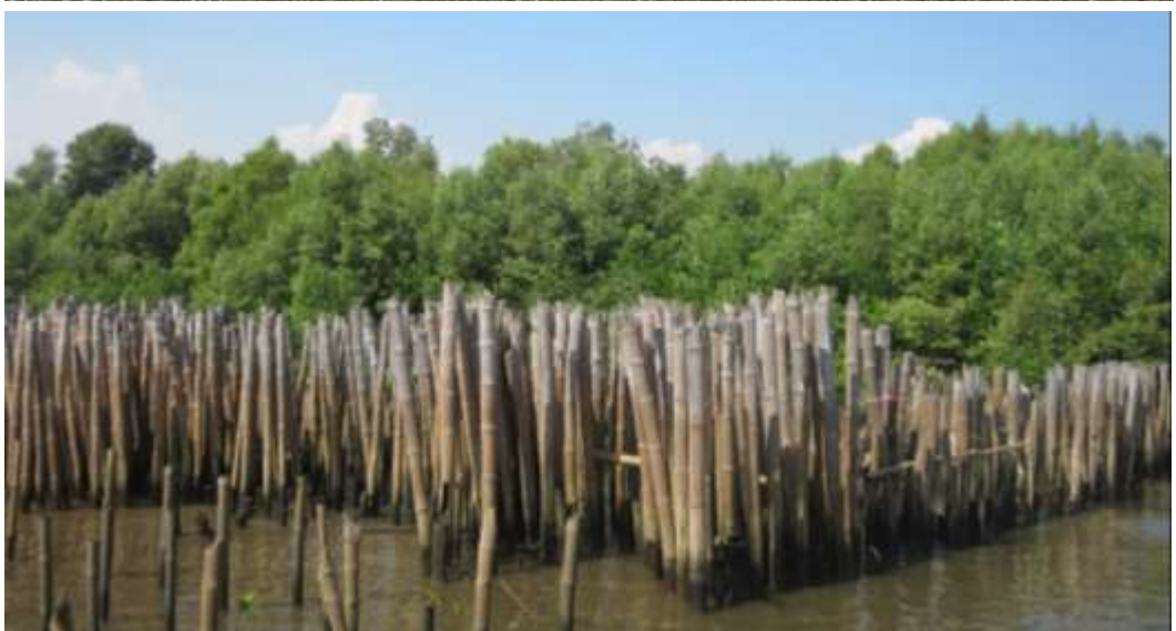
ภาพที่ 3.2 แนวปักไม้ไผ่ชะลอคลื่นที่ปักขนานกับแนวชายฝั่ง (ก) โดยมีการปักไม้ไผ่เสริมเป็นแนวตั้งฉากกับแนวชายฝั่งทะเลในระหว่างแนว (ข) และมีด้านปะทะคลื่นเป็นรูปสามเหลี่ยม (ค)
