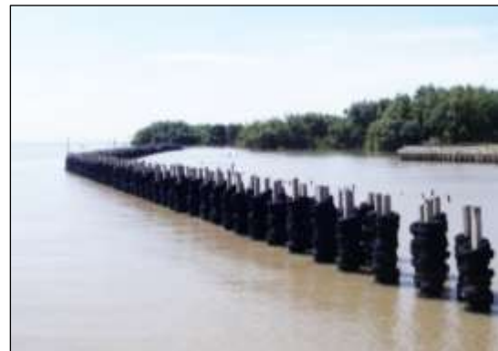
(ง) การสร้างเสาคอนกรีตหรือเสาเข็ม จังหวัด สมุทรปราการ
