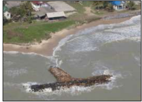
(ข) การสร้างรอดักทราย (groin) แบบตัวที บริเวณอำเภอรโนด จังหวัดสงขลา
