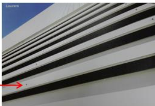
รูปภาพที่ 3. 11 แสดงบานเกล็ดช่องระบายอากาศในอาคารคลังสินค้าของโครงการ ทีพาร์ค
