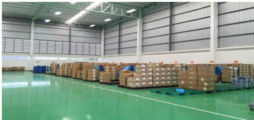
รูปภาพที่ 5. 26 พื้นประเภท Epoxy ที่ใช้ในคลัง
