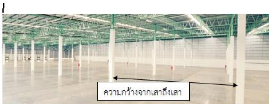
รูปภาพที่ 5. 29 แสดงความกว้างของเสาภายในอาคารคลังสินค้า
