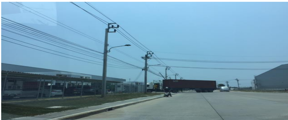
รูปภาพที่ 6. 21 แสดงความกว้างของถนนภายในโครงการ
