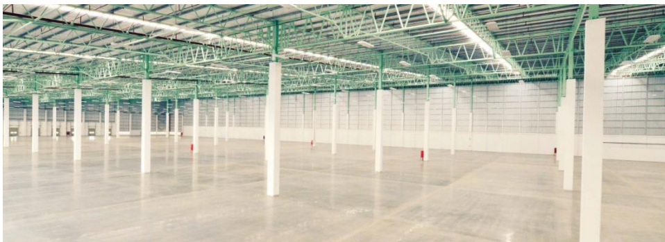
รูปภาพที่ 3. 13 แสดงการออกแบบความกว้างของเสาภายในอาคารคลังสินค้าของโครงการ ทีพาร์ค
