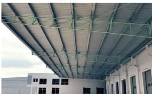
รูปภาพที่ 3. 31 แสดงความสูงของหลังคาต้านนอกอาคารคลังสินค้าที่ออกแบบให้สอดคล้องกับการไหลสินค้า ของโครงการ ทีพาร์ค
