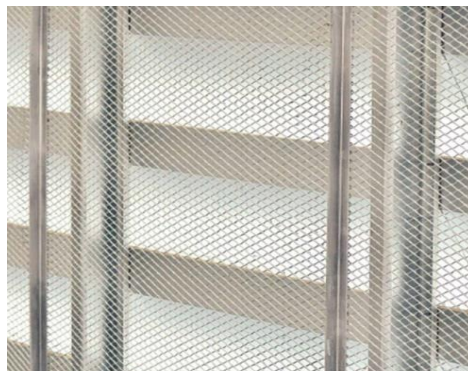
รูปภาพที่ 3. 17 แสดงการติดตั้งตาข่ายป้องกันสัตว์รบกวน ภายในอาคารคลังสินค้าของโครงการ ทีพาร์ค
