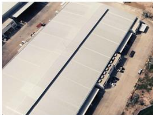
การเสริมคันทิ้งคา (Jack Roof)
