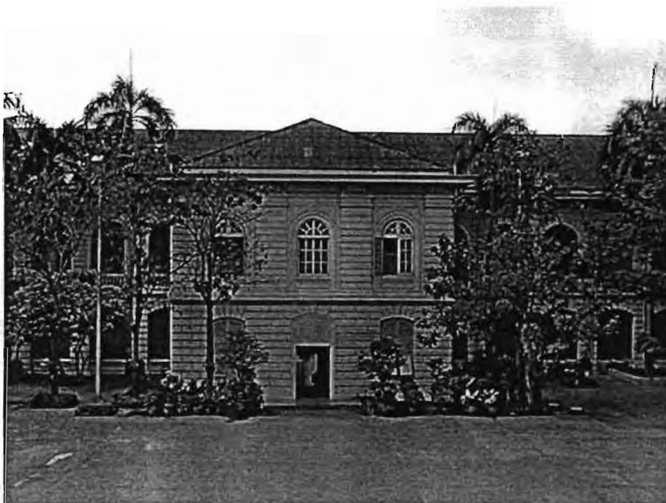
ภาพที่ 88 หลังคาของอาคารมุงด้วยกระเบื้องกระต่ายลอนเล็ก
