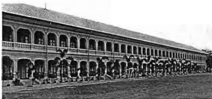
ภาพที่ 162 ตึกยาวโรงเรียนสวนกุหลาบวิทยาลัย มีการเปลี่ยนระบบโครงสร้างของฐานรากเป็นการใช้ระบบเข็มเจาะและเสาคานแทนระบบโครงสร้างแบบผนังรับน้ำหนักทั้งนี้เพราะพื้นดินมีการทรุดตัวอย่างต่อเนื่อง
