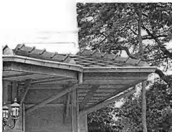
ภาพที่ 117 รางระบายน้ำผ่น พระตำหนักสวนบัวในพระที่นั่งดุสิต เป็นรูปแบบที่มักจะพบเห็นทั่วไปกับอาคารในยุค รัชกาลที่ 5
