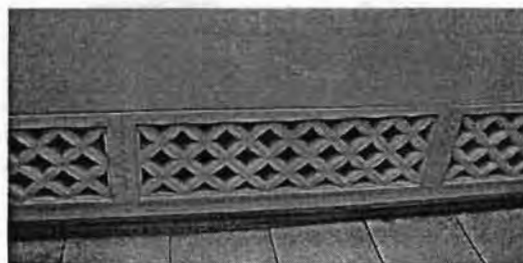
ภาพที่ 129 ช่องระบายอากาศเชิงผนังอาคารศาลาว่าการกระทรวงมหาดไทย
