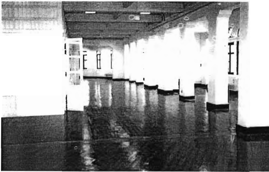
ภาพที่ 59 พื้นไม้ภายหลังการบูรณะแล้ว
