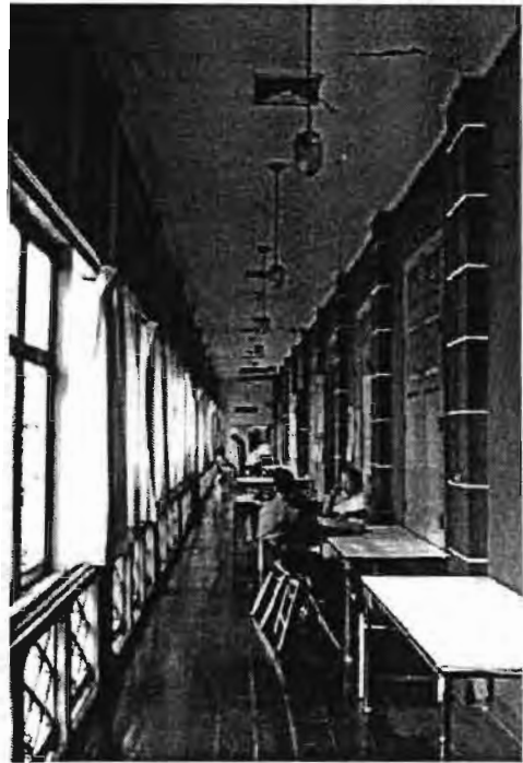
ภาพ 84 ระเบียงชั้น 2 ที่ถูกปรับเป็นพื้นที่ใช้งานมีการติดตั้งระบบปรับอากาศและประตูหน้าต่างเพิ่ม
