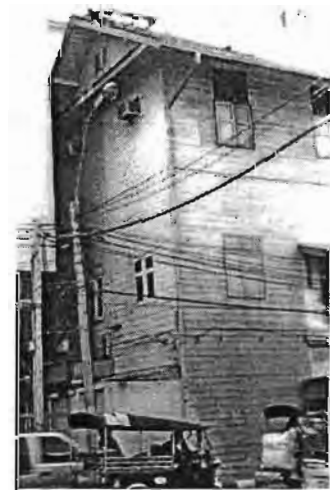
ภาพที่ 5 อาคารส่วนต่อเติมด้านถนนหลานหลวง
