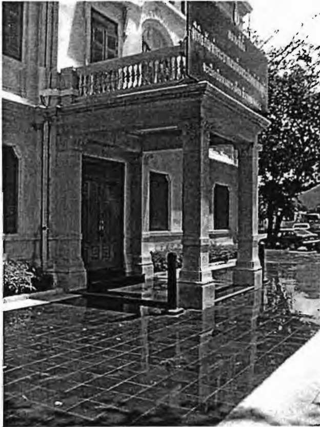
ภาพที่ 58 พื้นของบริเวณมุขทางเข้าด้านหน้าที่เรือเอวัสตุเดิมออกแล้วปูด้วยหินแกรนิตและหินอ่อนขัดมัน
