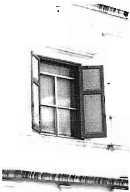
ภาพที่ 150 การเพิ่มหน้าต่างเพื่อตอบสนองการปรับการ ใช้งานโดยการใช้วัสดุในยุคสมัยปัจจุบัน ของอาคาร กระทรวงกลาโหม
