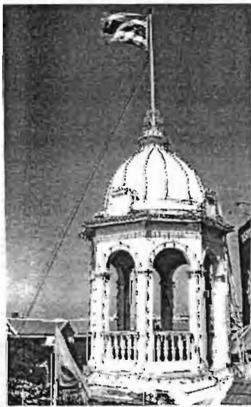
ภาพที่ 10 โดมเหนือหลังคาอาคารก่อนการบูรณะ
