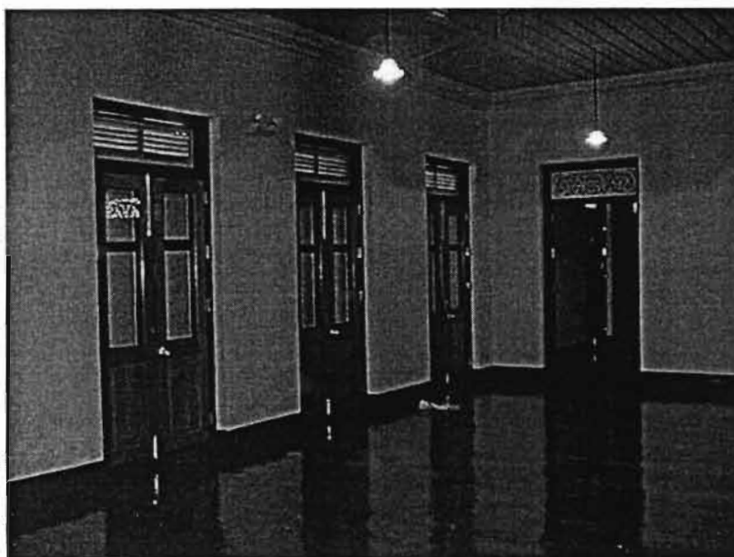
ภาพที่ 100 ประตูที่ติดตั้งเพิ่มรูปแบบใกล้เคียงกับประตูด้านนอกที่เป็นของเดิม
