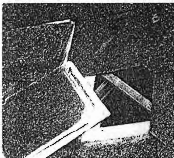
ภาพที่ 114 กระเบื้องแผ่นเรียบที่ใช้งมหลังคาของวังเทเวศม์
