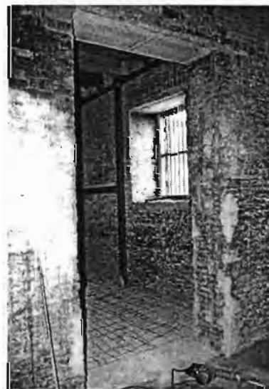
ภาพที่ 128 ผนังภายในที่ลอกผิวปูนฉาบออกเพื่อระบายความชื้น
