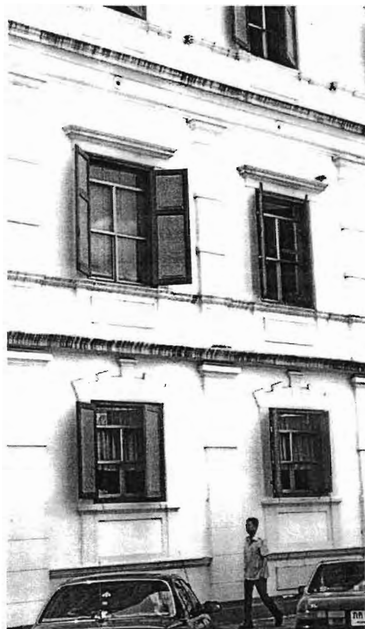
ภาพที่ 79 ช่องเปิดของอาคารที่ปรับเปลี่ยนเพื่อการติดตั้งระบบปรับอากาศ
