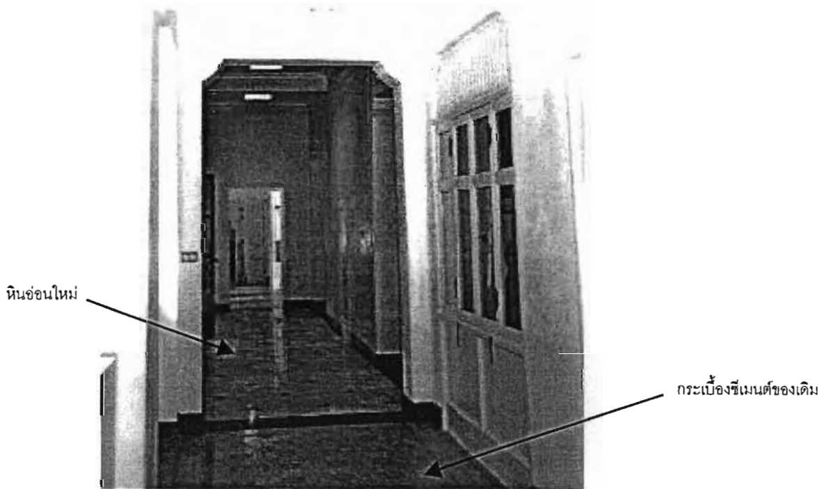
ภาพที่ 60 พื้นชั้นล่างหลังการบูรณะมีทั้งส่วนที่เป็นกระเบื้องเก่าและหินอ่อนที่เป็นของใหม่
