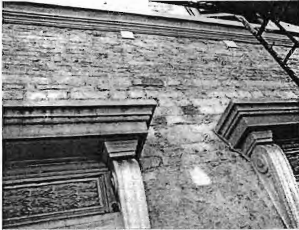
ภาพที่ 49 ผนังภายนอกที่ทำการลอกผิวปูนฉาบแล้วจึงซ่อมเปลี่ยนอิฐที่ชำรุด โดยยังคงบัวปูนปั้น และลวดบัวรอบอาคารไว้
