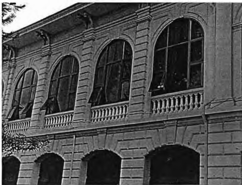
รูปภาพ 92 การติดตั้งหน้าต่างอลูมิเนียมบริเวณระเบียงด้านหน้าอาคาร
