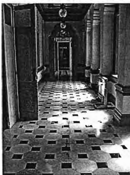
ภาพที่ 139 พื้นหินอ่อนของพระที่นั่งอัมพรสถาน เป็นพื้นหินอ่อนวางอยู่บนพื้นและโครงสร้างไม้บนผนังรับน้ำหนัก
