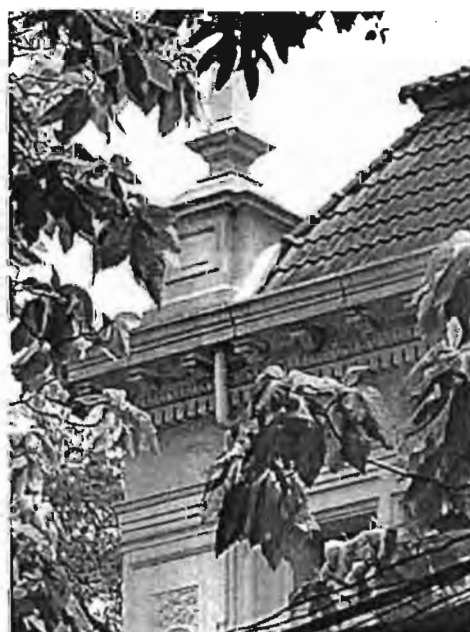
ภาพที่ 120 ชายคาและรางระบายน้ำคอนกรีตของ อาคารที่ได้รับการออกแบบมาพร้อมกับการก่อสร้าง อาคารมักมีการตกแต่งอย่างสวยงามด้วยลวดลายปูน ปั้น
