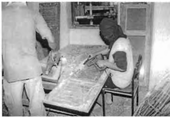
ภาพที่ 63 การลอกสีบานประตูหน้าต่างด้วยความร้อนก่อนการซ่อมแซม
