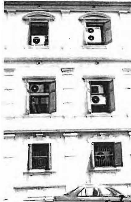
ภาพที่ 151 การการเพิ่มหน้าต่างเพื่อตอบสนอง การปรับการใช้งานสำหรับการติดตั้งเครื่องปรับ อากาศมีผลต่อความสวยงามของอาคาร กระทรวงกลาโหม
