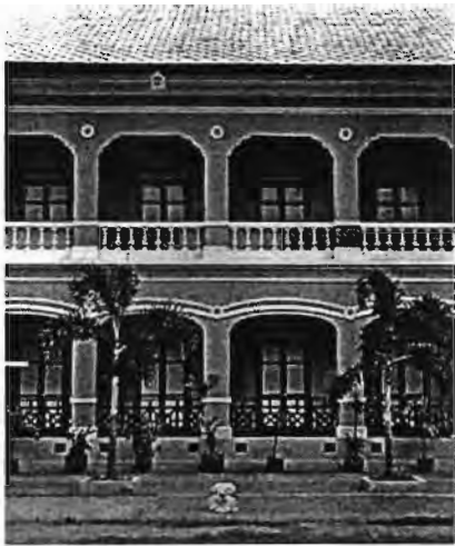
ภาพที่ 165 ตัวอย่างอาคารที่ใช้กระเบื้องเว้าซิเมนต์ในการบูรณะอาคาร
