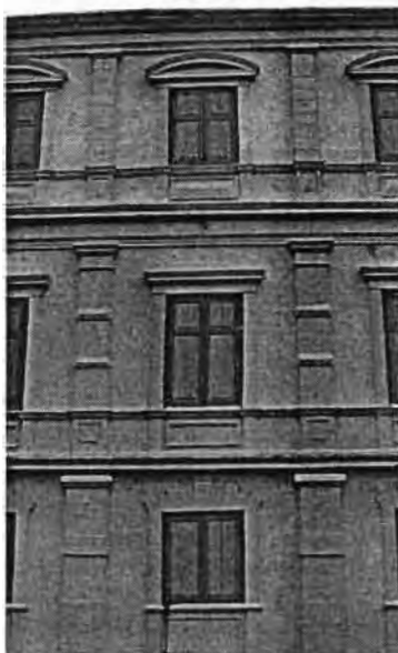
ภาพที่ 127 การฝังท่อระบายความชื้นบนผนังภายนอกของอาคารกระทรวงกลาโหม
