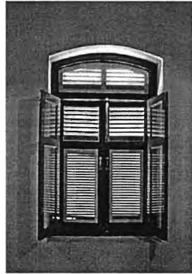
ภาพที่ 155 การปรับปรุงช่องเปิดเดิมโดยการเพิ่มบานเปิดด้านใน ลูกพักหน้าต่างเป็นกระจกใสของตึกยาวโรงเรียนสวนกุหลาบฯ
