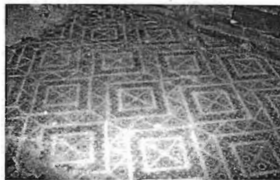
ภาพที่ 22 พื้นกระเบื้องซีเมนต์พิมพ์ลาย บริเวณชั้นล่างของอาคารก่อนการบูรณะ
