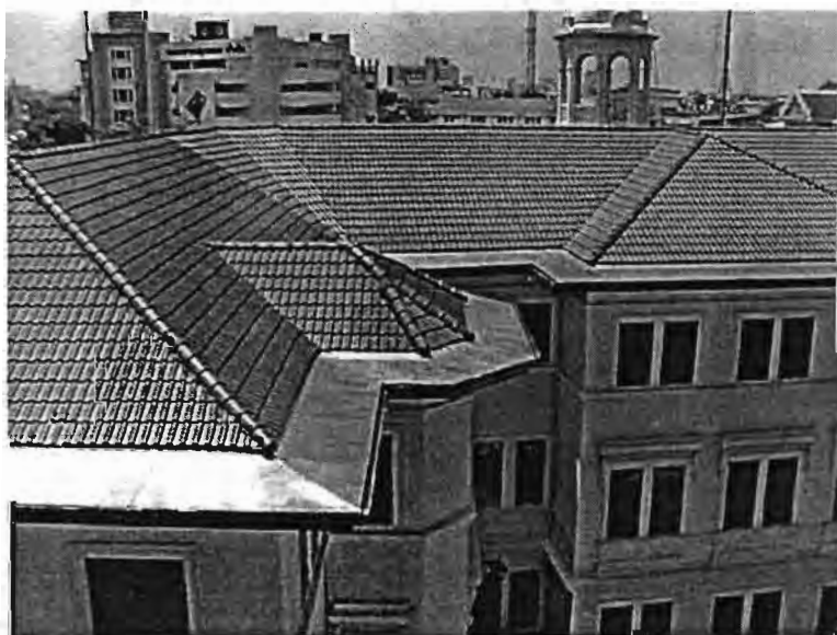
ภาพที่ 47 หลังคาของอาคารหลังการบูรณะ
