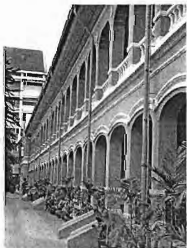
ภาพที่ 116 รางน้ำและ ท่อระบายน้ำผ่นของตึกยาวโรงเรียนสวนกุหลาบวิทยาลัย
