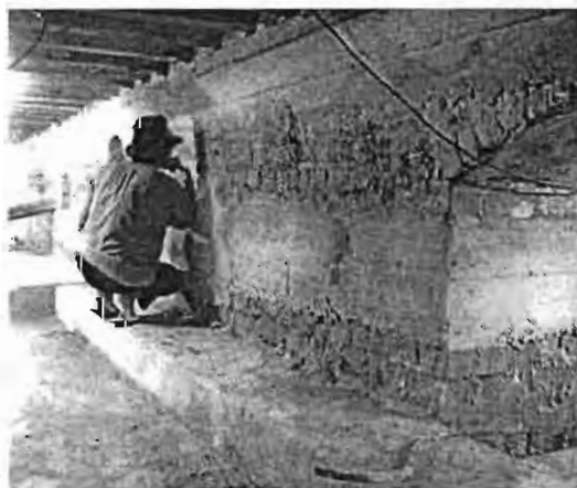
ภาพที่ 125 โครงสร้างและผนังชั้นใต้พื้นที่ 1 ที่ได้รับการใส่ชั้นป้องกันความชื้นแล้ว
