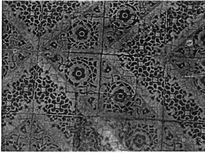
ภาพที่ 57 กระเบื้องที่ได้รับการซ่อมแซมด้วยกระเบื้องเดิม
