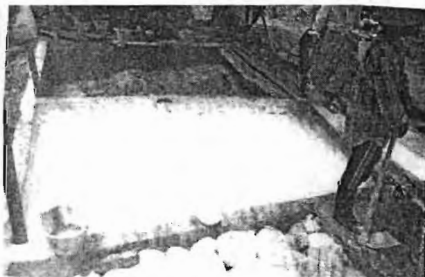
ภาพที่ 134 การหมักปูนสำหรับการอนุรักษ์ตามแบบโบราณ
