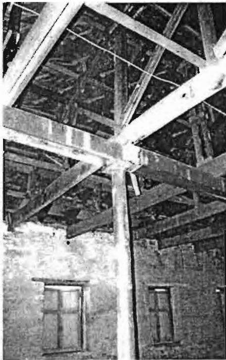
ภาพที่ 121 การเสริมโครงหลังคาของศาลาว่าการ กระทรวงกลาโหมด้วยไม้ใหม่แทนที่ของเก่า
