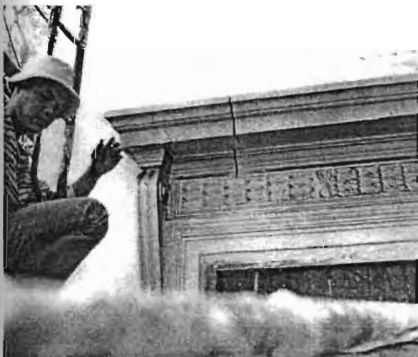
ภาพที่ 70 การลอกแบบหน้าตัดของบัวกับเสาตื้นของหน้าต่าง
