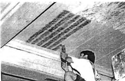
ภาพที่ 61 การลอกสีฝ้าเพดานเดิมด้วยความร้อน
