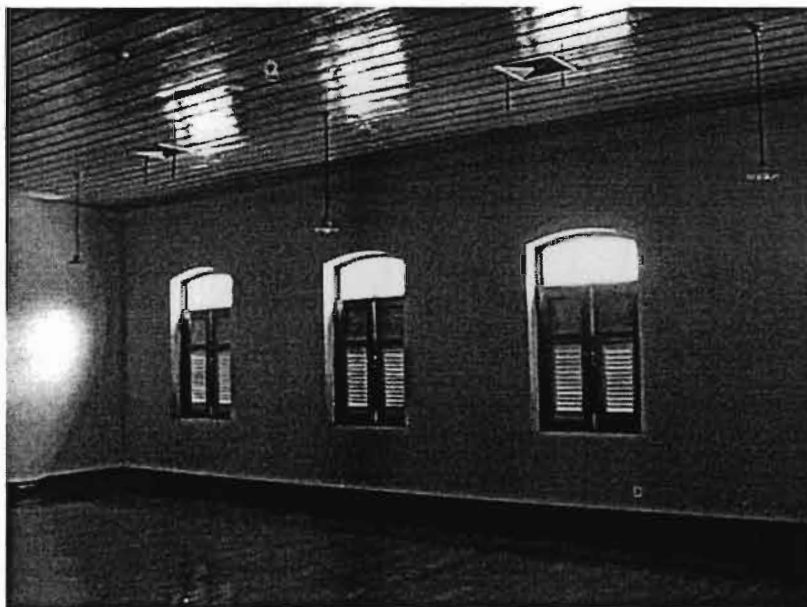
ภาพที่ 99 ภายในของอาคารที่ได้รับการบูรณะแล้วมีการติดตั้งหน้าต่างเพิ่มเพื่อติดเครื่องปรับอากาศ
