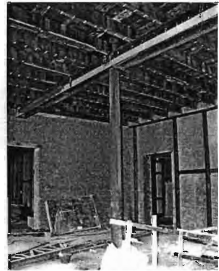
ภาพที่ 144 การเปลี่ยนเสาไม้ และคานไม้รับพื้นของอาคารกระทรวงกลาโหม
