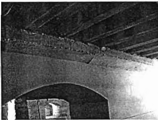
ภาพที่ 146 การเสริมบ่าคอนกรีตรับโครงสร้างพื้นของพระที่นั่งอัมพรสถาน
