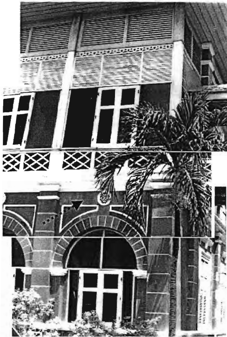
ภาพที่ 85 ระเบียงทางเดินด้านหน้าที่ถูกปรับเปลี่ยนเป็นพื้นที่ใช้งานทั้งชั้น1และชั้น2และสีที่มีความแตกต่างกันเป็นผลจากการซ่อมแซมโดยใช้สีต่างชนิดกัน
