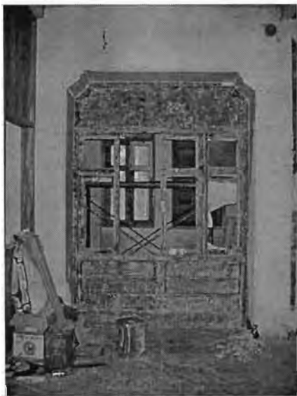
ภาพที่ 65 ผนังไม้และช่องเปิดภายในระหว่างการบูรณะ
