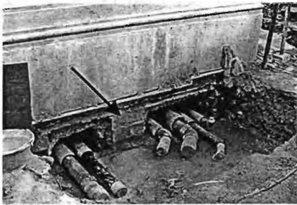
ภาพที่ 29 ฐานรากของอาคารที่มีลักษณะเป็นคลองราก
