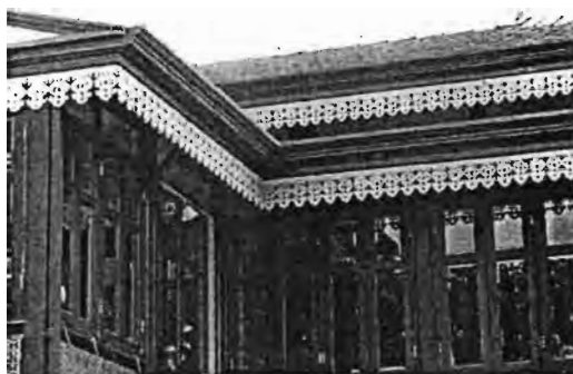
ภาพที่ 118 การทำรางน้ำซ้อนในชายคาของพระตำหนักหอ ใน พระราชวังดุสิต
