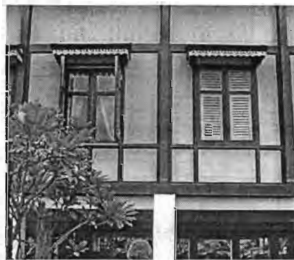
ภาพที่ 153 การปรับปรุงช่องเปิดเดิมโดยการ เปลี่ยนลูกฟักหน้าต่างเป็นกระจกใสในพระ ตำหนักหอ พระที่นั่งคูสิต
