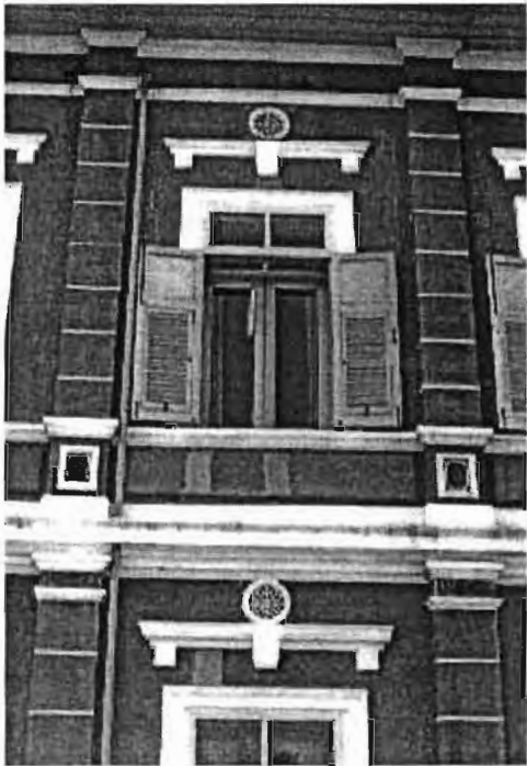
ภาพที่ 83 การเพิ่มหน้าต่างเพื่อติดตั้งระบบปรับอากาศ
