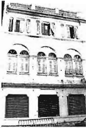
ภาพที่ 16 ผนังด้านหน้าอาคารก่อนการบูรณะ
