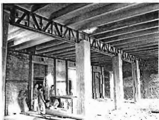
ภาพที่ 157 การเสริมเหล็กรูปพรรณบริเวณผนังเพื่อกระจายการรับน้ำหนักของชั้นล่างศาลาว่าการกระทรวงกลาโหม
