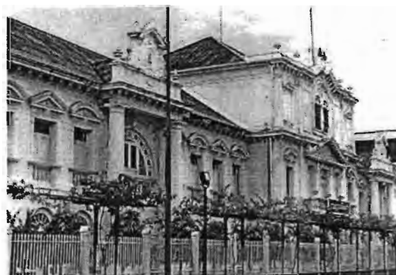
ภาพที่ 109 อาคารกรมแผนที่ทหาร ใช้กระเบื้องลอนเล็กในการบูรณะ
