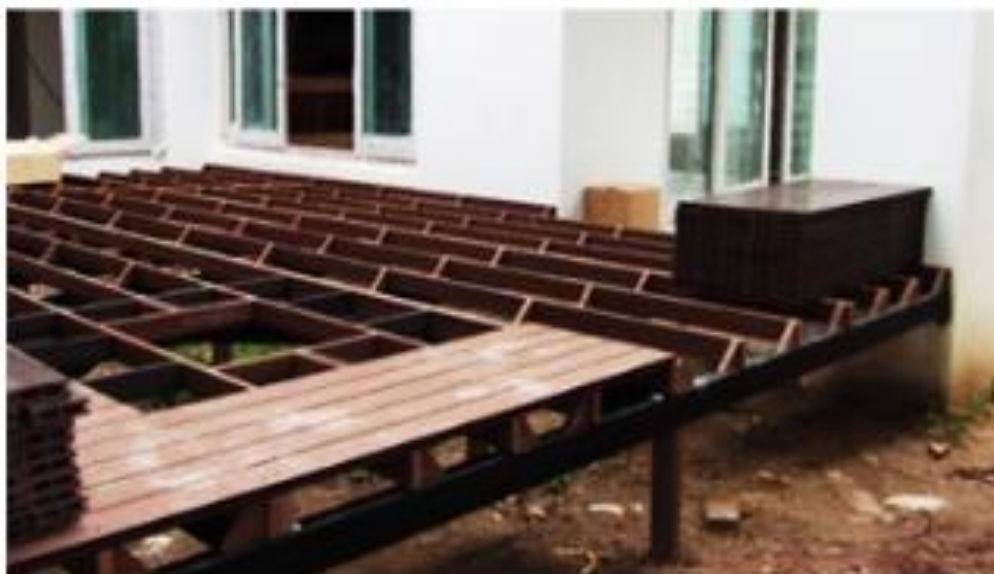
รูปที่ 48 การทดสอบการติดตั้ง
