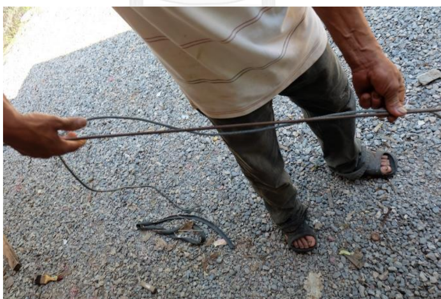
ภาพที่ 254 การวัดเหล็กเส้นด้วยเชือก
