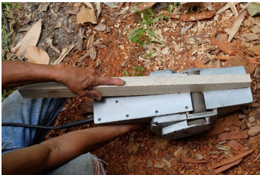
ภาพที่ 267 การตกแต่งไม้ด้วยกบไฟฟ้า
