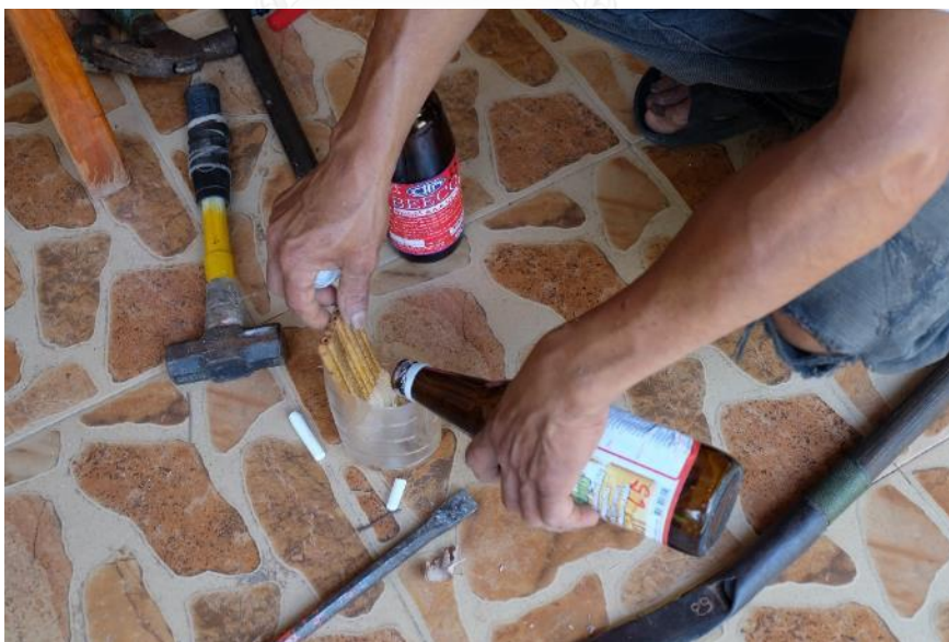
ภาพที่ 276 การชุบน้ำยาเคลือบพื้นไม้
