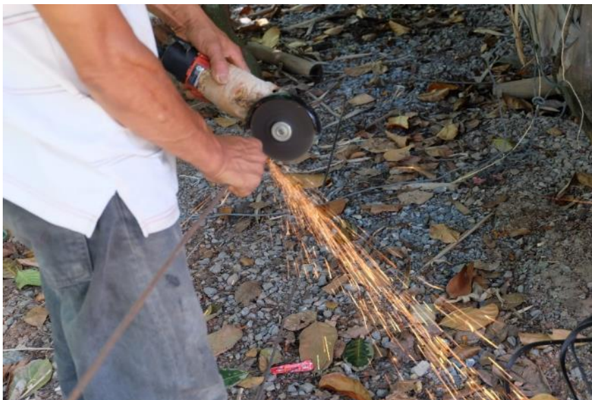
ภาพที่ 255 การตัดเหล็ก
