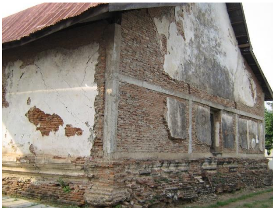
ภาพที่ 185 วิหารพระนอน วัดสามวิหาร ในปี พ.ศ. 2549 เห็นหลังคาสังกะสีจากการปฏิสังขรณ์ในปี พ.ศ. 2525 และโครงสร้างคอนกรีตเสริมเหล็กจากการสงวนรักษา สภาพในปี พ.ศ. 2527 ที่มา: gis.finearts.go.th
