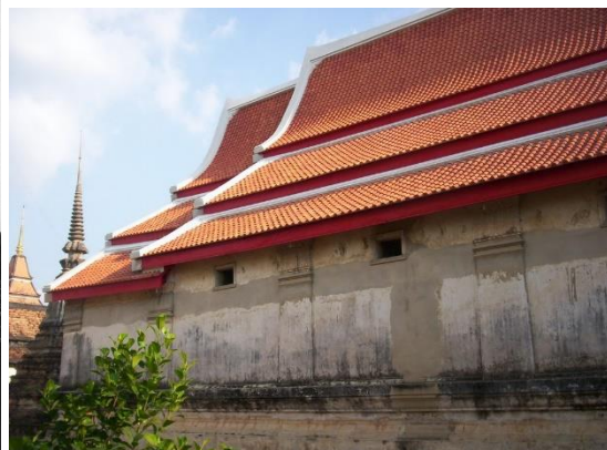
ภาพที่ 192 พระอุโบสถ วัดพุทไธสวรรย์ ในปี พ.ศ. 2549 เห็นช่องแสงที่เจาะในการปฏิสังขรณ์ในสมัยรัชกาลที่ 6 ที่มา: gis.finearts.go.th
