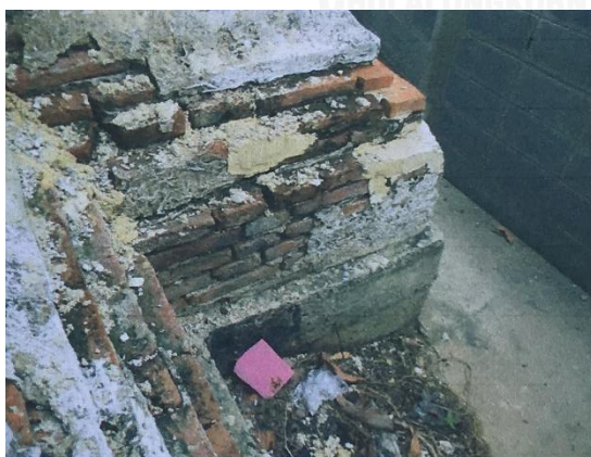
ภาพที่ 189 การสกัดอิฐที่เสื่อมสภาพก่อใหม่ เจดีย์เล็ก วัด สามวิหาร ในการปฏิสังขรณ์ในปี พ.ศ. 2555
