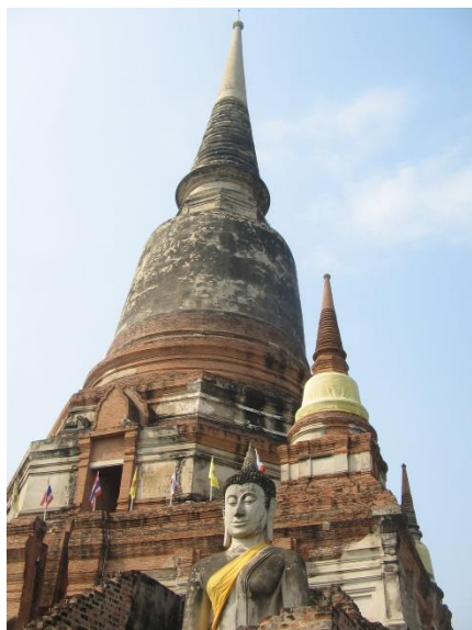
ภาพที่ 205 เจดีย์ประธาน วัดใหญ่ชัยมงคล ในปี พ.ศ. 2549 เห็นสภาพหลังจากปฏิสังขรณ์โดยมีการก่ออิฐและฉาบปูนใหม่บางส่วนในช่วงระหว่างปี พ.ศ. 2522-2525
