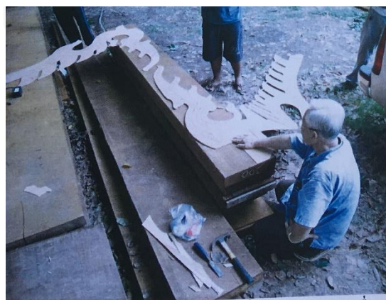
ภาพที่ 182 การกะสวนแบบเครื่องลำยองพระอุโบสถ วัด กษัตราธิราชวรวิหาร ตามรูปแบบเดิม ในการปฏิสังขรณ์ ในปี พ.ศ. 2557
