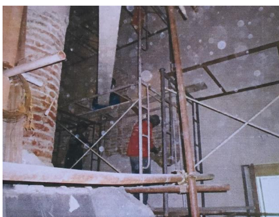
ภาพที่ 181 การสกัดผิวปูนฉาบเดิมที่ผนังภายในพระ อุโบสถ วัดกษัตราธิราชวรวิหาร เพื่อฉาบใหม่ด้วยปูนหมัก แบบโบราณ ในการปฏิสังขรณ์ในปี พ.ศ. 2557
