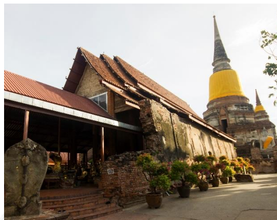
ภาพที่ 206 อุโบสถ วัดใหญ่ชัยมงคล ได้รับการปรับการใช้สอยในปี พ.ศ. 2522 ด้วยการต่อเติมโครงสร้างผนังและหลังคาใหม่โดยไม่กระทบซากผนังเดิม
