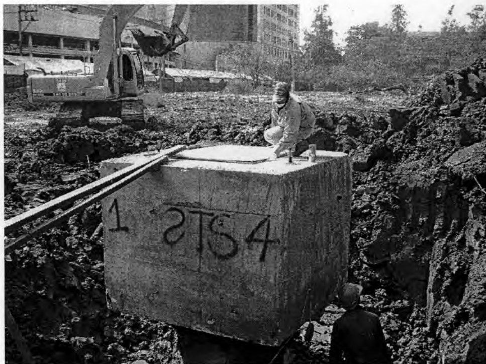
รูปที่ ก.3 การติดตั้งแผ่นไม้อัดสำหรับกระจายหน่วยแรงไปยังเสาเข็มเจาะทดสอบ
