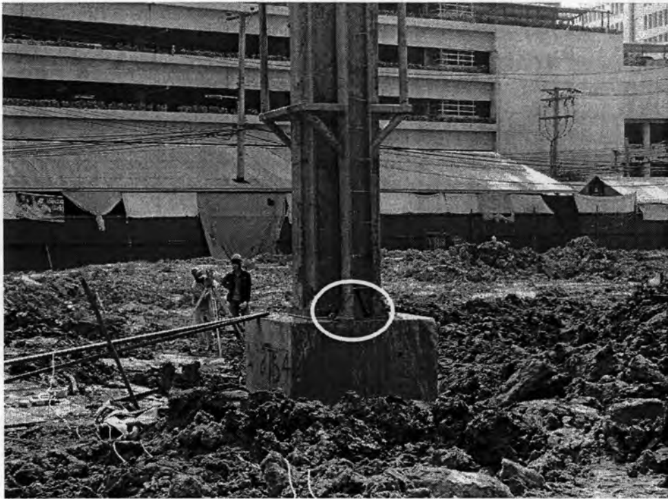
รูปที่ ก.7 การติดตั้ง Guide frame เข้ากับ Pile Cap ที่มีการติดตั้ง Bolts ไว้ก่อนหน้า
