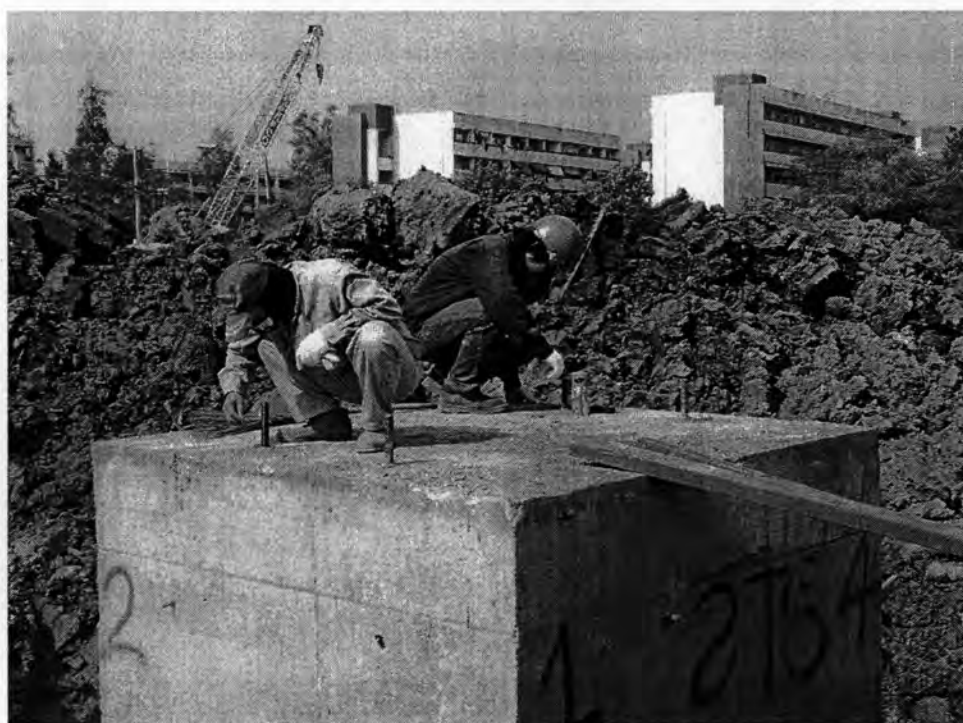
รูปที่ ก.2 การทำความสะอาด Bolts ที่มีการติดตั้งพร้อมกับการก่อสร้าง Pile Cap
