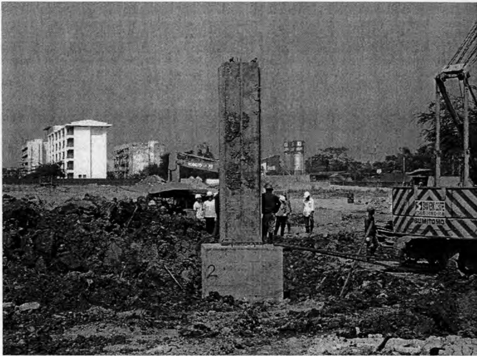
รูปที่ ก.5 การติดตั้งตุ้มเหล็กโดยมีน้ำหนักขนาด 20 ตัน บน Pile Cap
