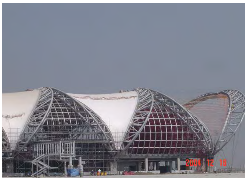
รูปที่ 7.6 แสดงหลังคาฝ้าใยสังเคราะห์ของอาคารเทียบเครื่องบิน
