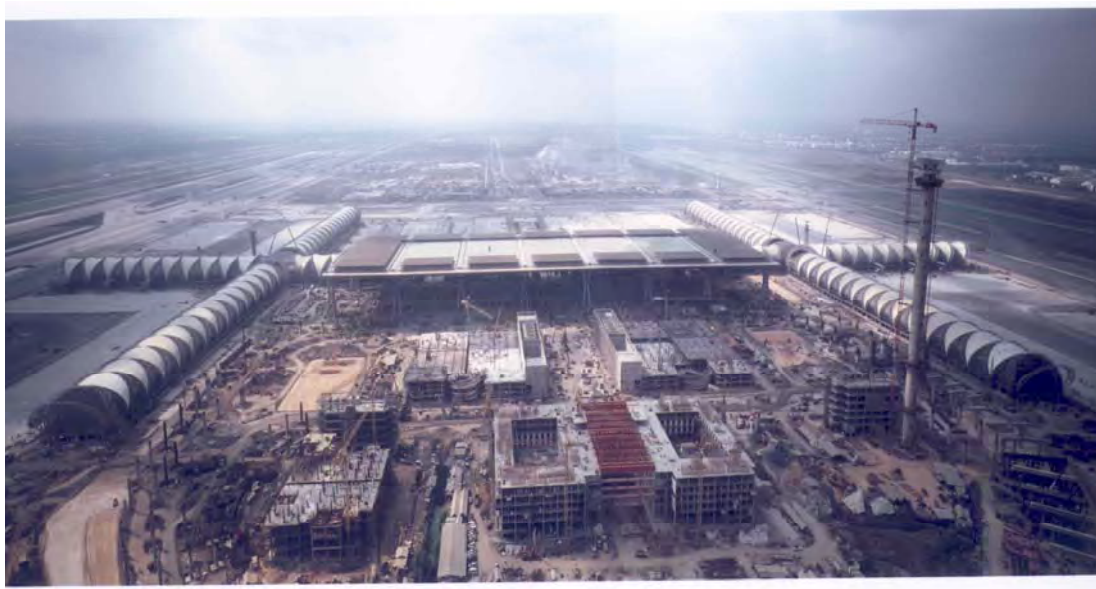
รูปที่ 9.5 แสดงอาคารผู้โดยสารและอาคารเทียบเครื่องบินที่ถูกล้อมรอบไปด้วยโครงการก่อสร้างอื่นๆ จำนวนมาก
