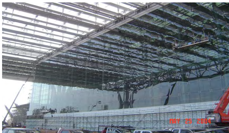
รูปที่ 7.5 แสดงผนังกระจกภายนอกอาคารผู้โดยสาร
