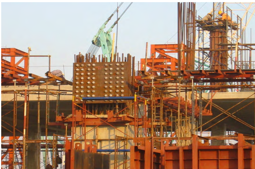
รูปที่ 7.8 แสดงจุดรับน้ำหนัก (anchor bolt) คานคอนกรีตเสริมเหล็ก
