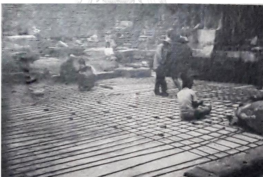
ภาพที่ 46 การปรับปรุงรากฐานและเสริมความมั่นคง โดยบดอัดหินให้แน่นแล้วเทด้วยคอนกรีต เสริมเหล็ก ที่มา : อุทยานประวัติศาสตร์พนมรุ้ง
