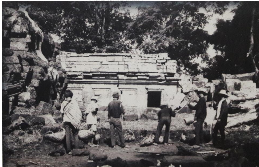
ภาพที่ 44 การจัดทำผังรูปแบบ บันทึกสภาพของโบราณสถานที่เหลืออยู่อย่างละเอียดทั้งผังพื้น รูปด้านตั้งของโบราณสถานทั้ง 4 ด้าน ซึ่งนำมาใช้ในการวิเคราะห์รูปดั้งเดิมก่อนพังทลาย
