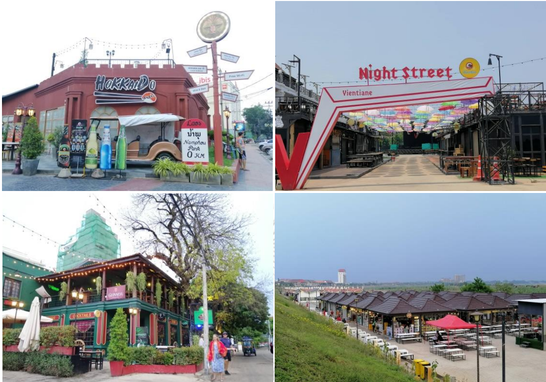
ภาพที่ 29 อาคารพาณิชย์กรรม
