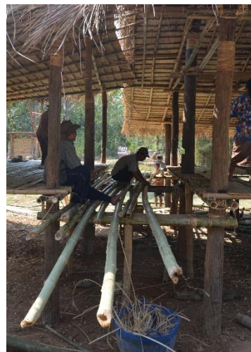
ขั้นตอนการติดตั้งตงพื้นกลุโคะ
