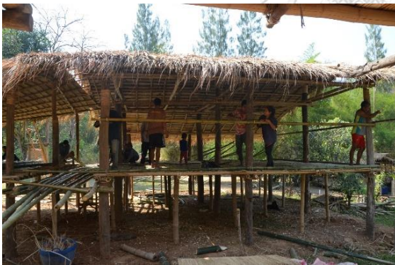
ขั้นตอนการติดตั้งโครงผนัง
