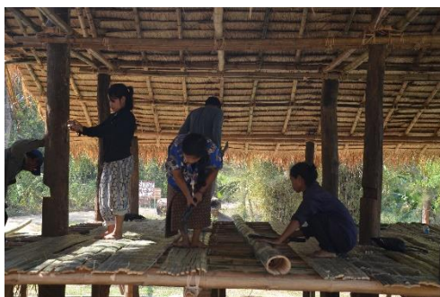
รูปที่ 68 ภาพถ่ายแร้งงานรับจ้างรายวันกำลังสับฟากไม้ไผ่
