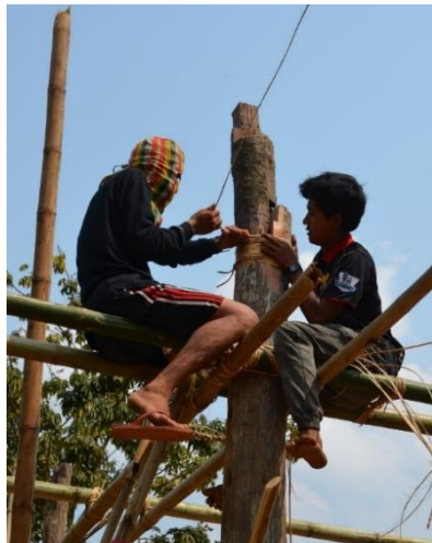
รูปแบบการมัดหวายแบบต่อหัวเสา 2
