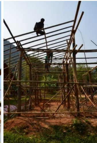
ขั้นตอนการติดตั้งอกไก่ และจันทัน
