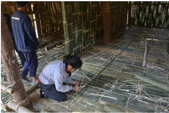
ขั้นตอนการติดตั้งไม้ขนานหลังฟาก
