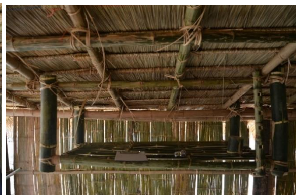
ภาพชั้นวางจานชามที่เสร็จสมบูรณ์
