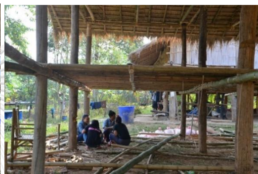
ขั้นตอนการติดตั้งเสาหมอรับตง 1
