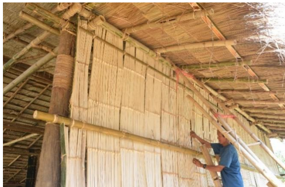
ขั้นตอนการติดตั้งไม้ขนานหลังฟากบริเวณผนัง
