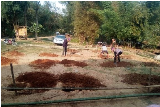
ขั้นตอนการขุดหลุมเสา จำนวน 18 ต้น
