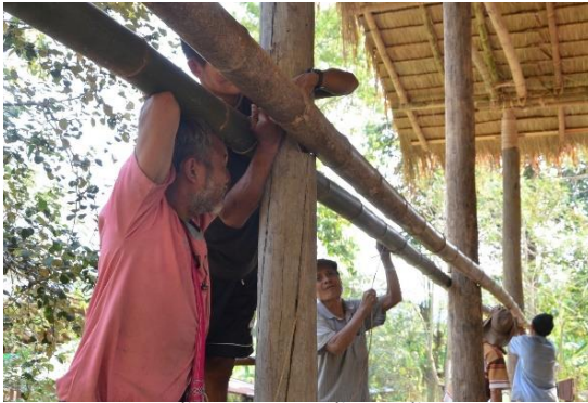
ขั้นตอนการติดตั้งคานพื้น
