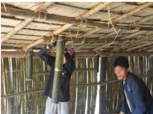
ขั้นตอนการติดตั้งชั้นวางจานชาม
