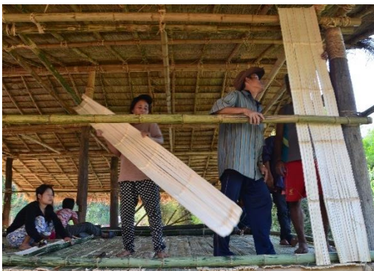
ขั้นตอนการติดตั้งผนังฟากไม้ไผ่
