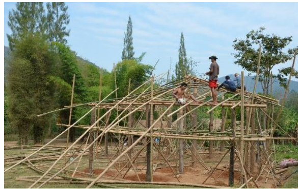
ขั้นตอนการติดตั้งจันทันรับพะไล
