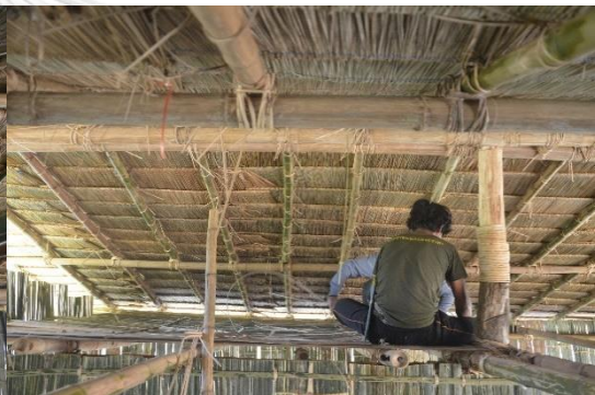
ขั้นตอนการปูพื้นฟากชั้นเก็บของ
