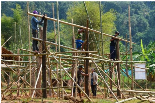
ขั้นตอนการติดตั้งแปหัวเสา
