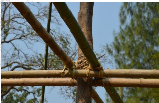
รูปแบบการมัดหวายแบบเงื่อนคาคอไก่
