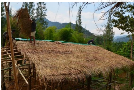
ขั้นตอนการปูพลาสติกกันรั้วซีมบริเวณกรอบสันหลังคา
