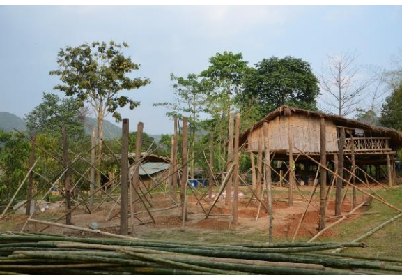
ขั้นตอนตั้งค้ำยันเสาไม้ 1
