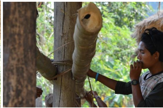
ขั้นตอนการมัดหวายแบบเงื่อนคาคอไก่บริเวณคานพื้น
