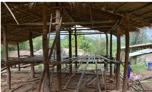
ขั้นตอนการติดตั้งคานพื้น
