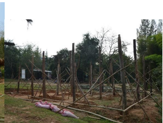
ขั้นตอนการตั้งค้ำยันเสาไม้ 2
