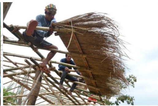
ขั้นตอนการมุงหลังคาหญ้าคา
