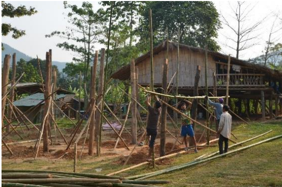
ขั้นตอนการติดตั้งนั่งร้านไม้ไผ่ 1
