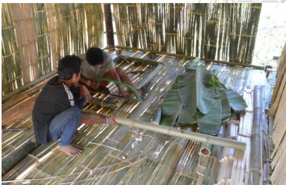
ขั้นตอนการติดตั้งเตาไฟ
