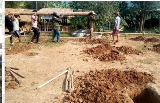
ขั้นตอนการลำเลียงเสาหลุม
