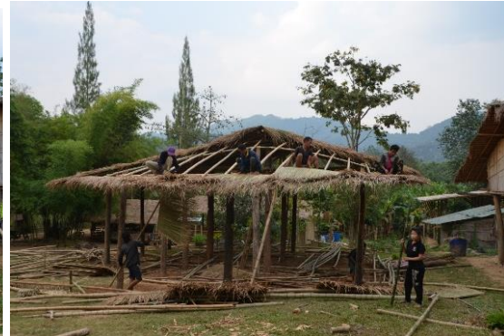
ขั้นตอนการมุงหลังคาหญ้าคาบริเวณพะไล
