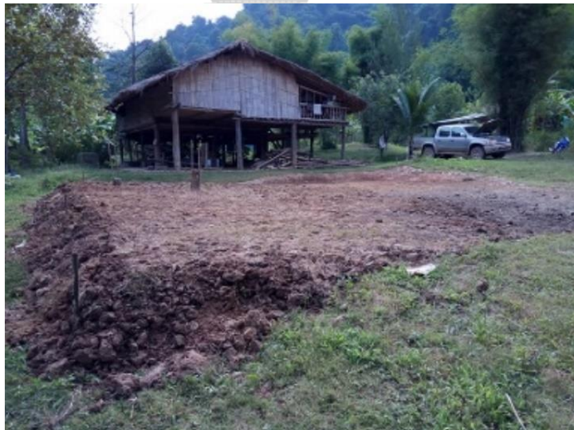
รูปที่ 12 ภาพถ่ายบริเวณพื้นที่ก่อสร้าง
