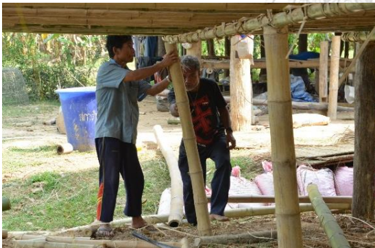
ขั้นตอนการติดตั้งเสาหมอรับตง 2
