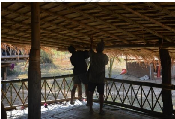
รูปที่ 61 ขั้นตอนการเก็บรายละเอียดปลายหวายบริเวณโครงสร้างหลังคา
