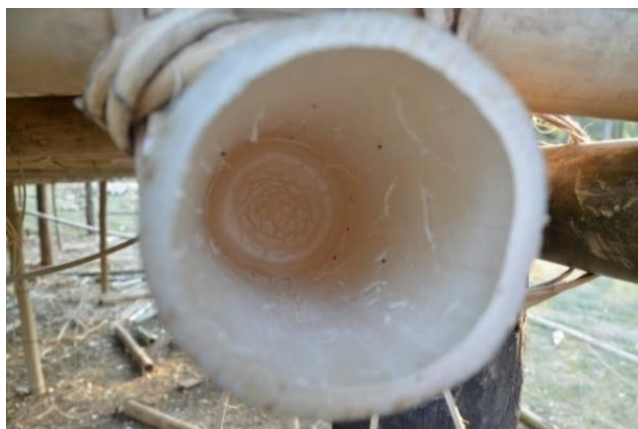
รูปที่ 62 ภาพถ่ายการฝังตัวของมอดและแมลงในเนื้อไม้ไผ่
