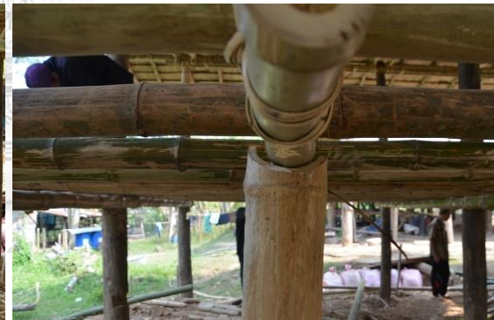
รูปแบบการบากหัวเสาหมอรับตง
