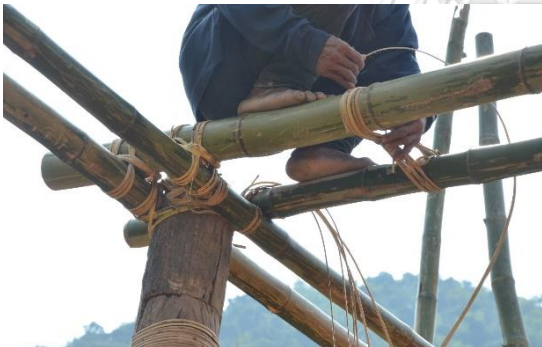
รูปแบบการมัดหวายแบบเงื่อนหูกะพง
