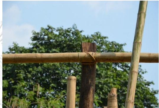
รูปแบบการมัดหวายแบบเงื่อนคาคอไก่
