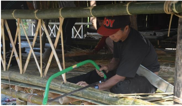
ขั้นตอนการติดตั้งลูกขัดกรอบระเบียง
