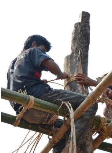
รูปแบบการมัดหวายแบบต่อหัวเสา 1
