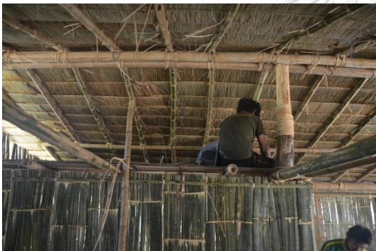
ขั้นตอนการติดตั้งชั้นเก็บของบริเวณเหนือห้องนอนลูกสาว
