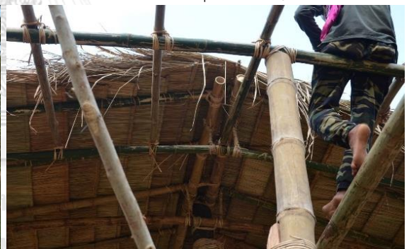
ขั้นตอนการมุงกรอบสันหลังคาชั้นบนสุด
