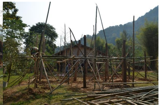
ขั้นตอนการติดตั้งนั่งร้านไม้ไผ่ 2
