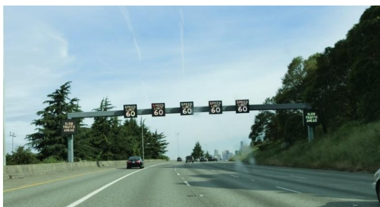
รูปที่ 1.1 ป้ายจราจรขีดจำกัดความเร็วแบบปรับเปลี่ยน
