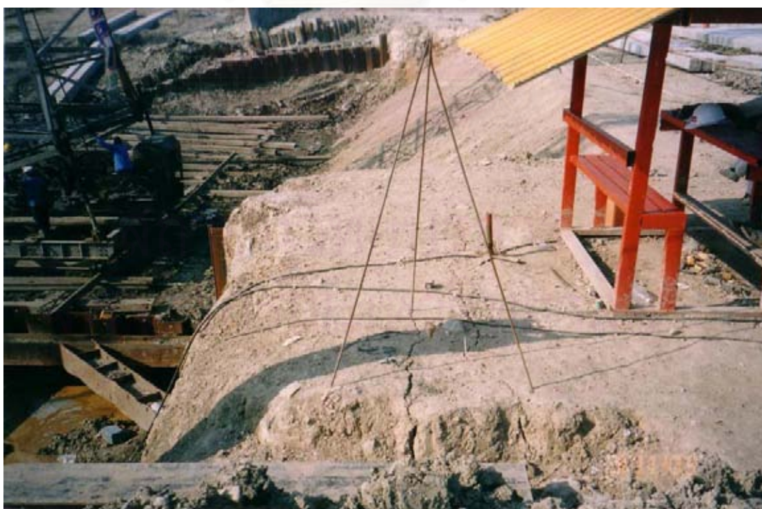
รูปที่ 3.32 แสดงงานตัดลาดเสาเข็มซีเมนต์เพื่อลดการเคลื่อนตัว และงานตอกเสาเข็ม
