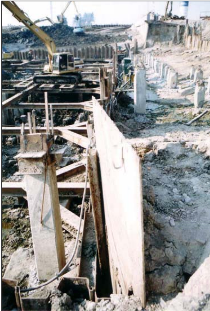
รูปที่ 4.6 ภาพขั้นตอนการก่อสร้าง ก) และค่าการเคลื่อนตัวของโครงสร้างกันดินฝั่งซ้าย
