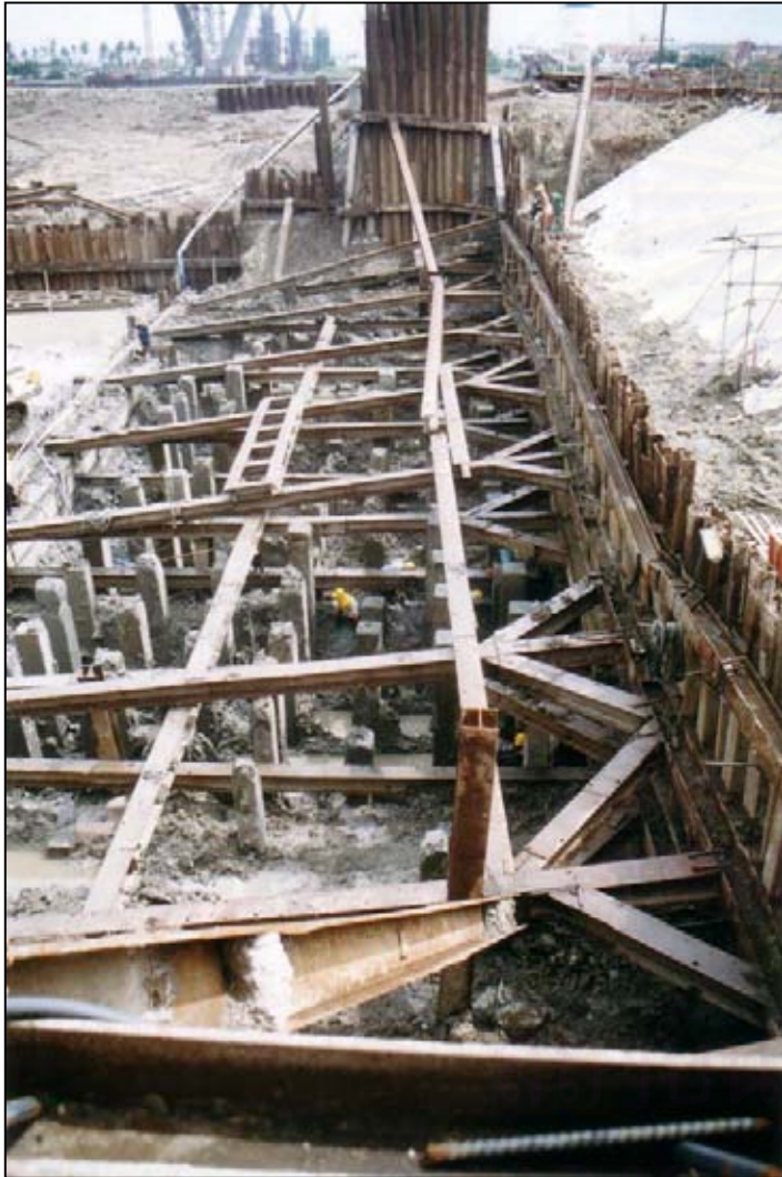
รูปที่ 4.9 ภาพขั้นตอนการก่อสร้าง ง) และค่าการเคลื่อนตัวของโครงสร้างกันดินฝั่งซ้ายซ้าย
