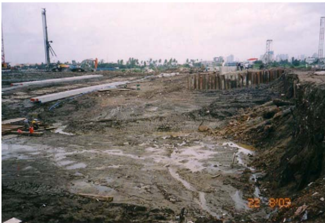
รูปที่ 3.31 แสดงงานขุดในแนวตั้ง จนกระทั่งเสาเข็มซีเมนต์ฝังชำยวิบัติ
