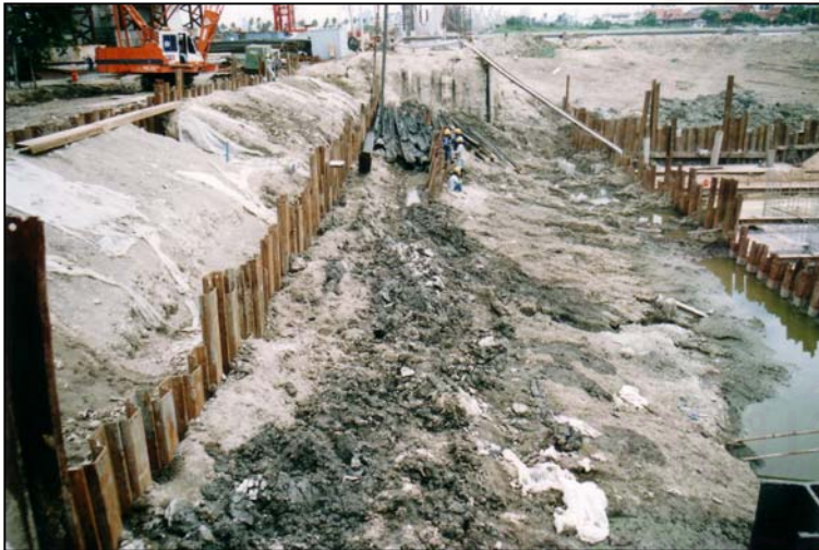
รูปที่ 4.13 ภาพขั้นตอนการก่อสร้าง ก) และค่าการเคลื่อนตัวของโครงสร้างกันดินฝั่งขวา
