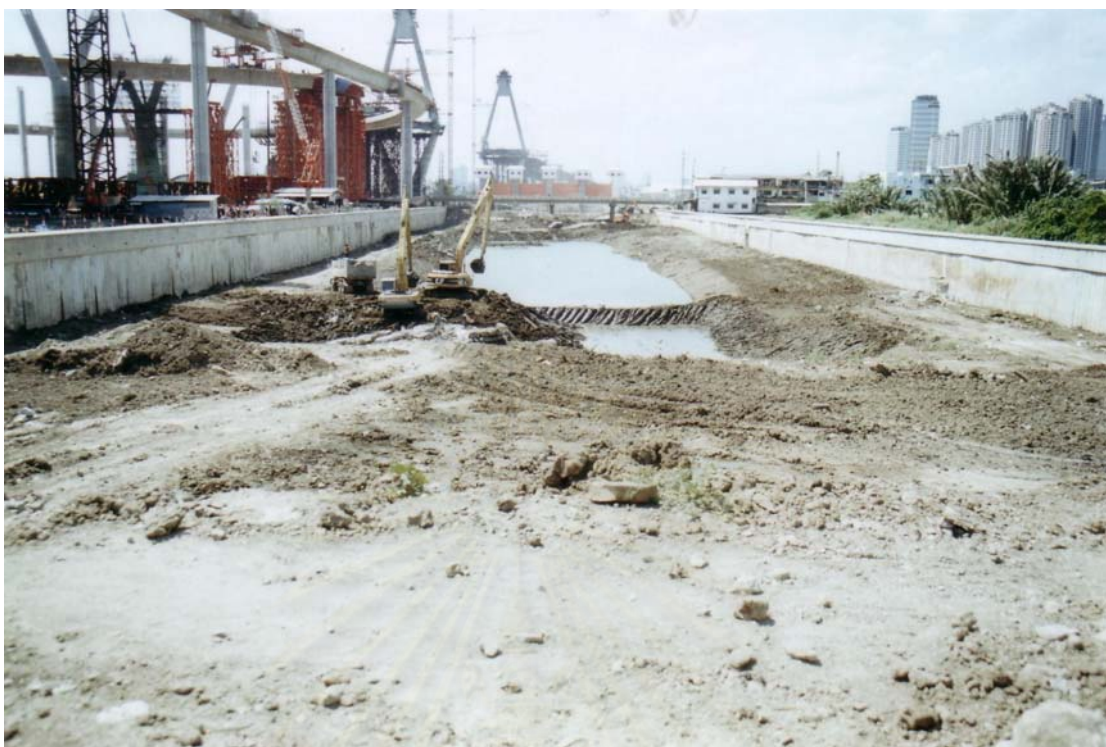
รูปที่ 3.45 แสดงงานขุดคลองถึงระดับ -7.00 ม.รทก. และทิ้งชานคลองความกว้าง 9.50 ม.
