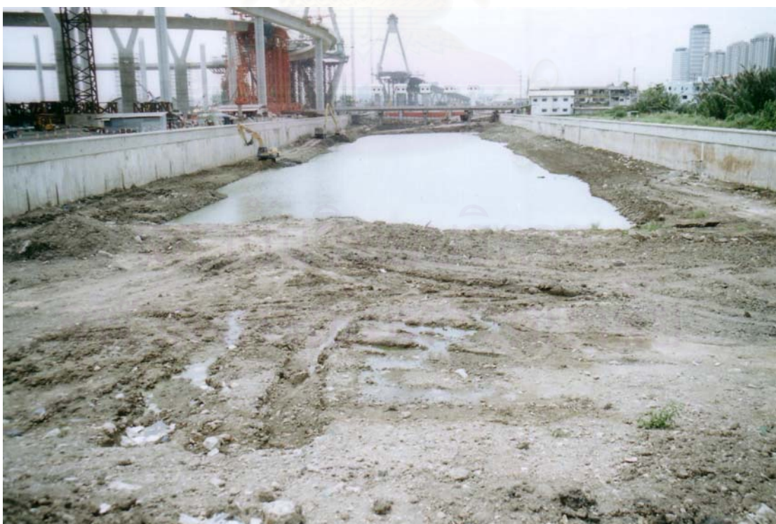
รูปที่ 3.46 แสดงงานเติมน้ำถึงระดับ -3.00 ม.รทก. และลดขนาดชานคลองกว้าง 5.00 ม.
