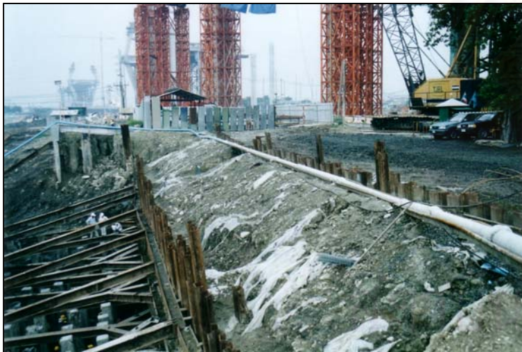
รูปที่ 4.16 ภาพขั้นตอนการก่อสร้าง ง) และค่าการเคลื่อนตัวของโครงสร้างกันดินฝั่งขวาซ้าย
