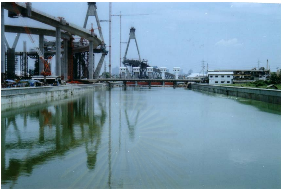
รูปที่ 3.47 แสดงงานเติมน้ำถึงระดับ -1.00 ม.รทก. เสร็จสิ้นขั้นตอนงานขุดแห้งคลอง
