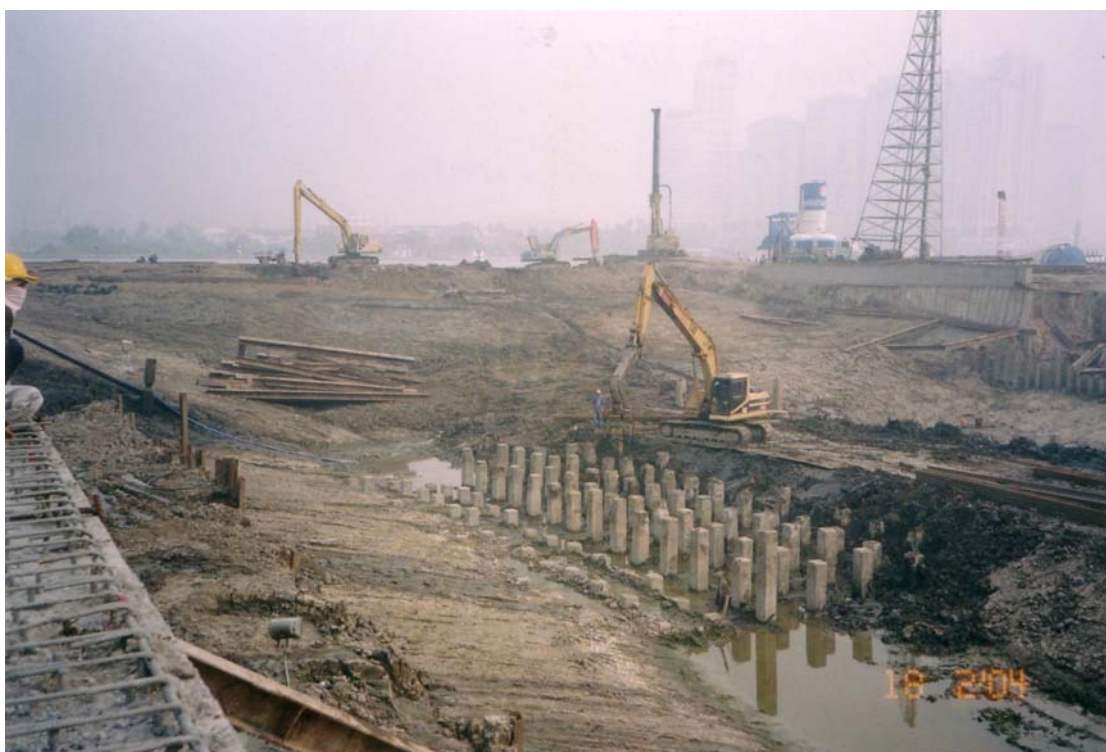
รูปที่ 3.33 แสดงงานขุดดินพื้น P2L และ P2M ด้วยเข็มพืดเหล็ก
