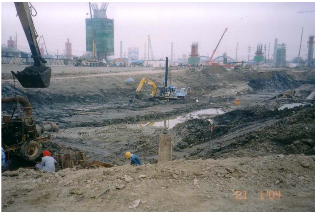
รูปที่ 3.43 แสดงงานขุดส่วนกลางคลองถึงระดับ -3.00 ม.รทก. เพื่อก่อสร้างเสาหินซีเมนต์
