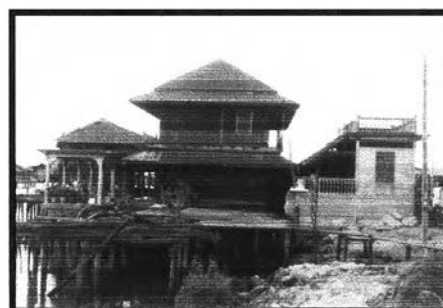
ภาพที่ 4.26 อาคารเก่าที่อยู่ในชุมชน
