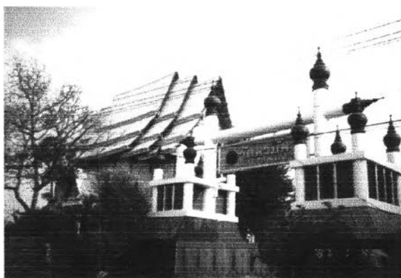
ภาพ 3.21 วัดพายัพและพระอุโบสถหลังใหม่ที่กำลังก่อสร้าง
