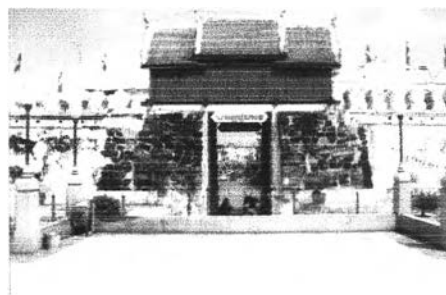
ประตูชุมพล ด้านทิศตะวันตกเป็นประตูที่ยังเหลือหลักฐานดั้งเดิมให้เห็นเด่นชัด ผ่านการบูรณะหลายครั้ง
