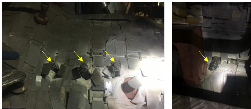
รูปที่ 2.19 ช่องสำหรับ Bore Scope เพื่อตรวจสอบสภาพเครื่องกังหันก๊าซ
