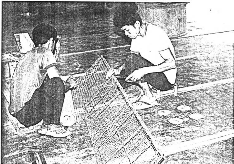
ภาพประกอบที่ 43 การขีคลวดตาข่ายกับโครงเหล็กเสริม
