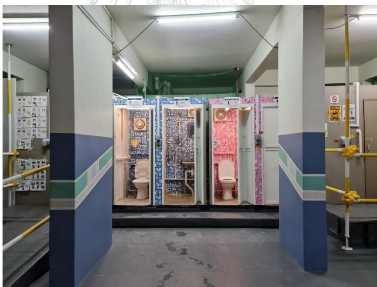
ภาพ 52 ห้องน้ำและห้องอาบน้ำชั่วคราวในชั้นล่างของอาคารที่กำลังถูกบูรณะ
