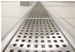
ตัวอย่างรางระบายน้ำ
